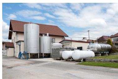
Réservoirs. Phot. Sonia Dourlot IVR43_20192500620NUC4A
