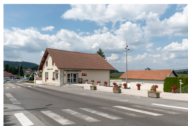
Vue d'ensemble, depuis le nord. Phot. Sonia Dourlot IVR43_20192500614NUC4A
