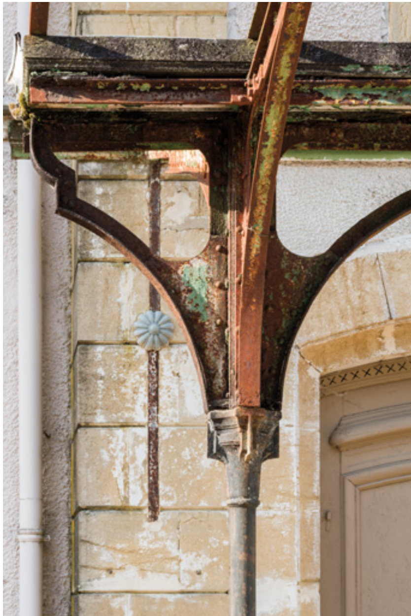
Marquise de la façade sur l'avenue, détail.
