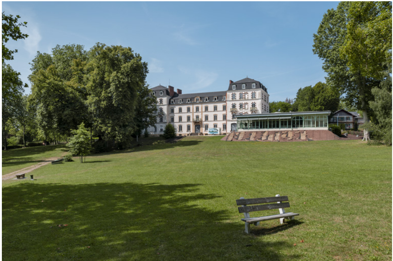
Vue d'ensemble depuis le parc thermal.
