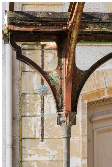
Marquise de la façade sur l'avenue, détail.
