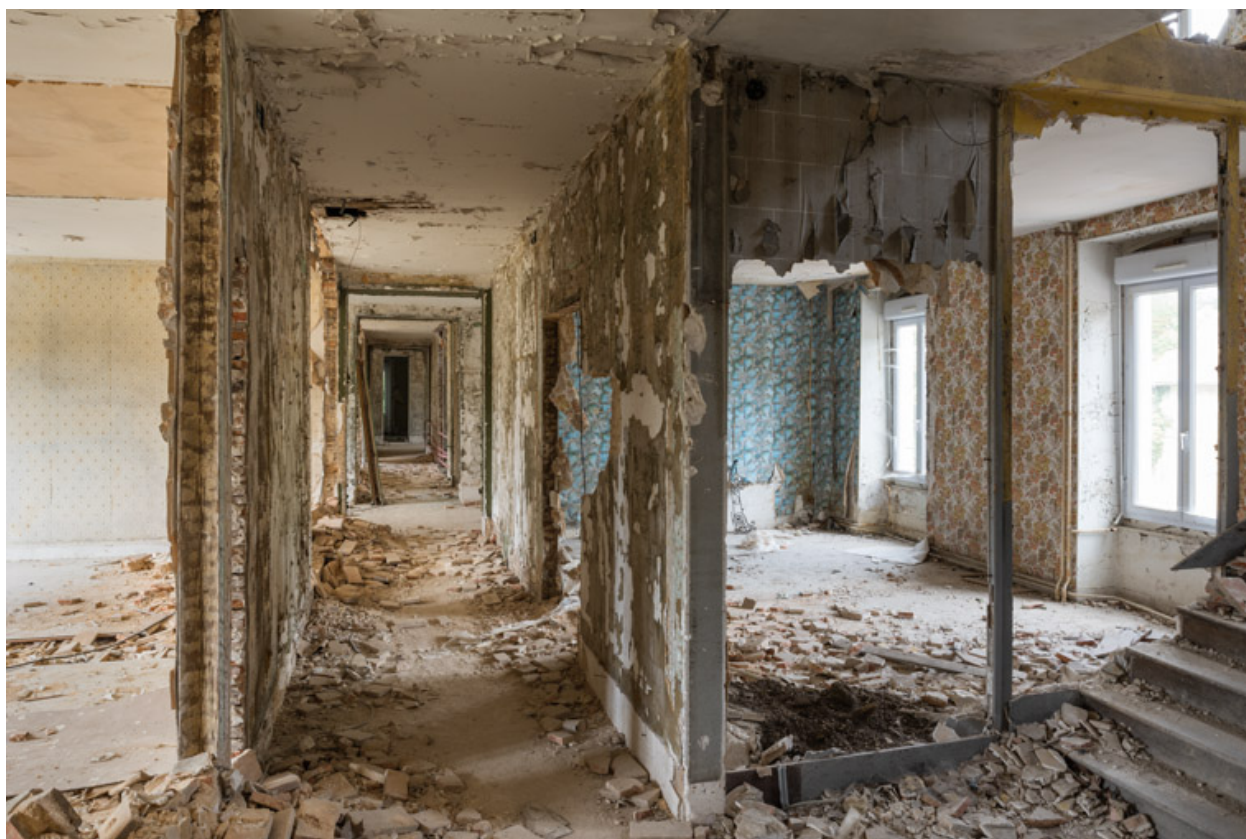
Couloir et chambres au premier étage.
