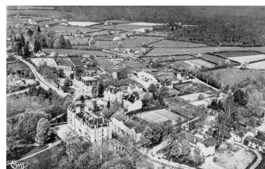
Vue aérienne. Autr. auteur inconnu IVR26_20195800125NUC2A
