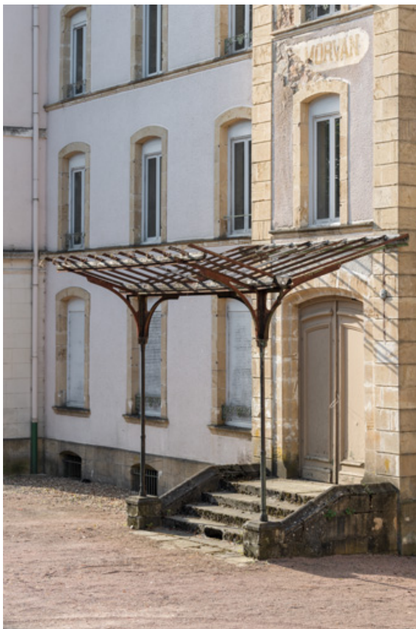
Marquise de la façade sur l'avenue.
