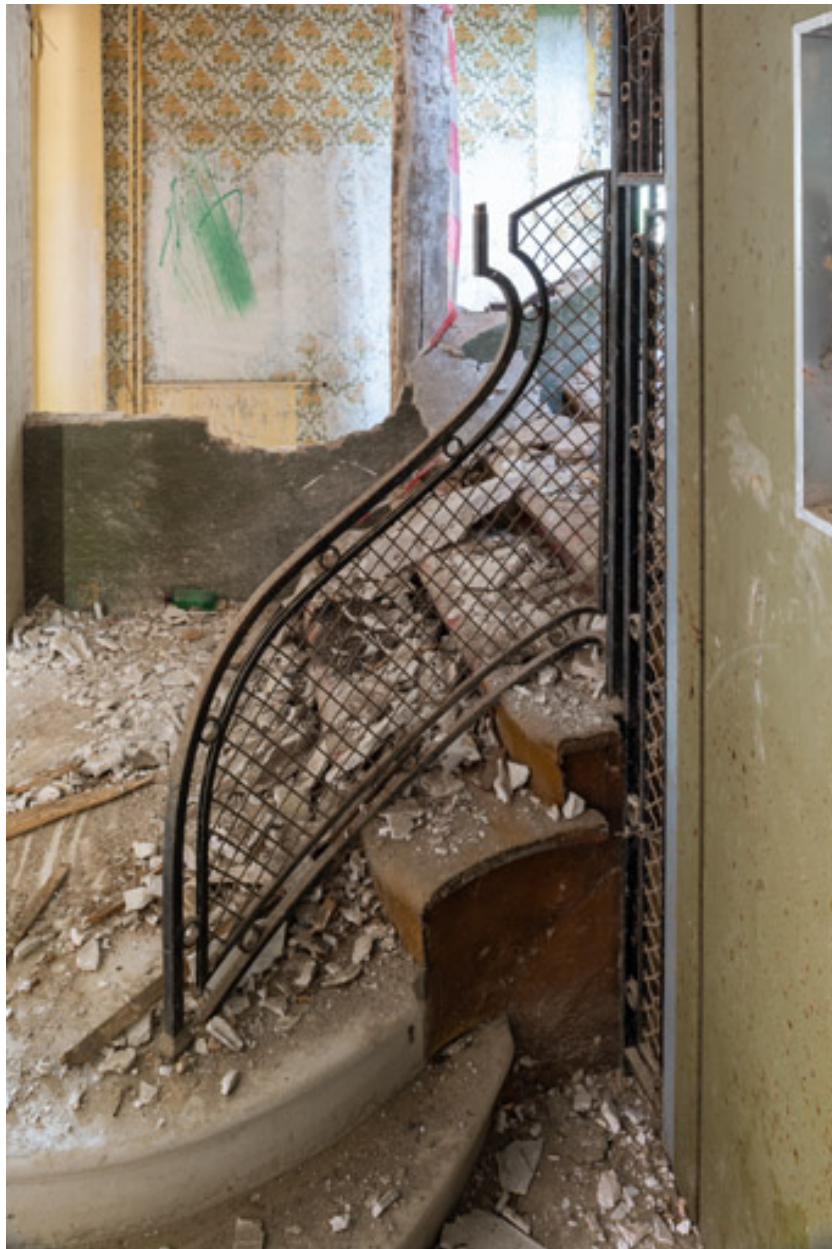
Escalier ouest, détail, rampe d'appui.
