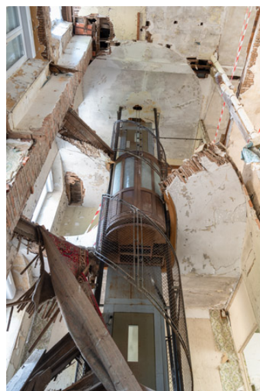
Ascenseur de l'escalier ouest, vue d'ensemble après l'effondrement des planchers. Phot. Pierre-Marie Barbe-Richaud IVR26_20195800573NUC4A
