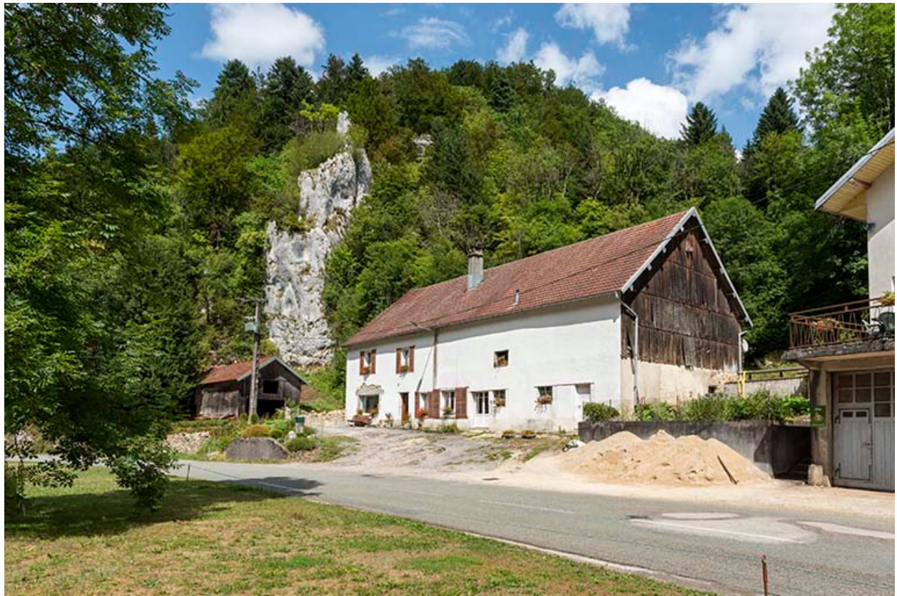
Logement (avec les anciennes grange et étable).
