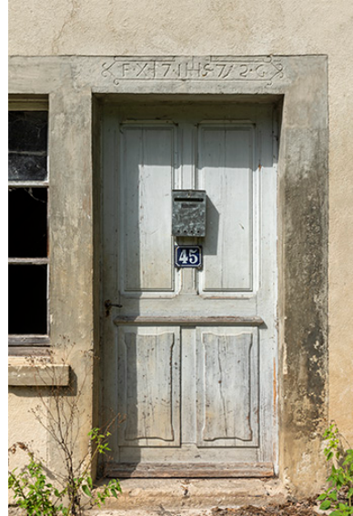
Porte avec linteau daté 1772. Phot. Sonia Dourlot IVR43_20192500719NUC4A
