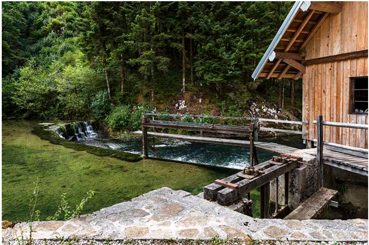
Barrage et vannes.
