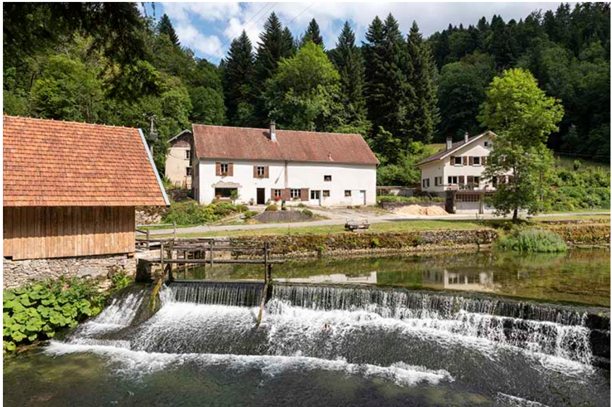
Vue d'ensemble depuis l'ouest (rive gauche).
