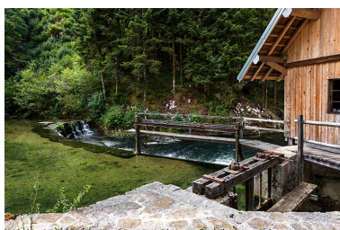
Barrage et vannes. Phot. Sonia Dourlot IVR43_20192500708NUC4A
