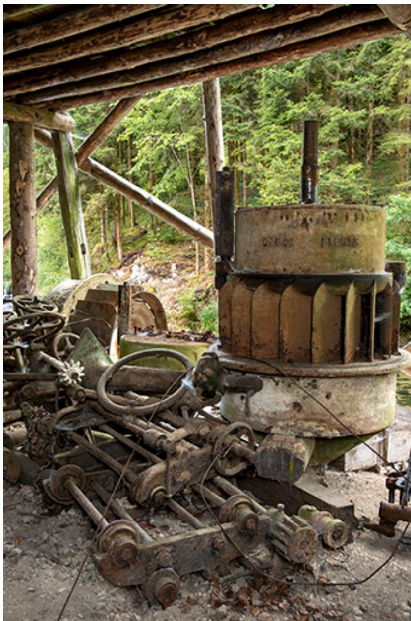
Turbine Douge et transmission démontées.
