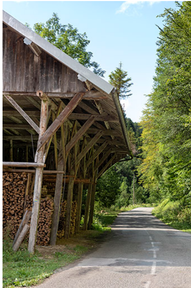
Hangar, depuis le sud. Phot. Sonia Dourlot IVR43_20192500703NUC4A
