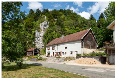
Logement (avec les anciennes grange et étable). Phot. Sonia Dourlot IVR43_20192500715NUC4A
