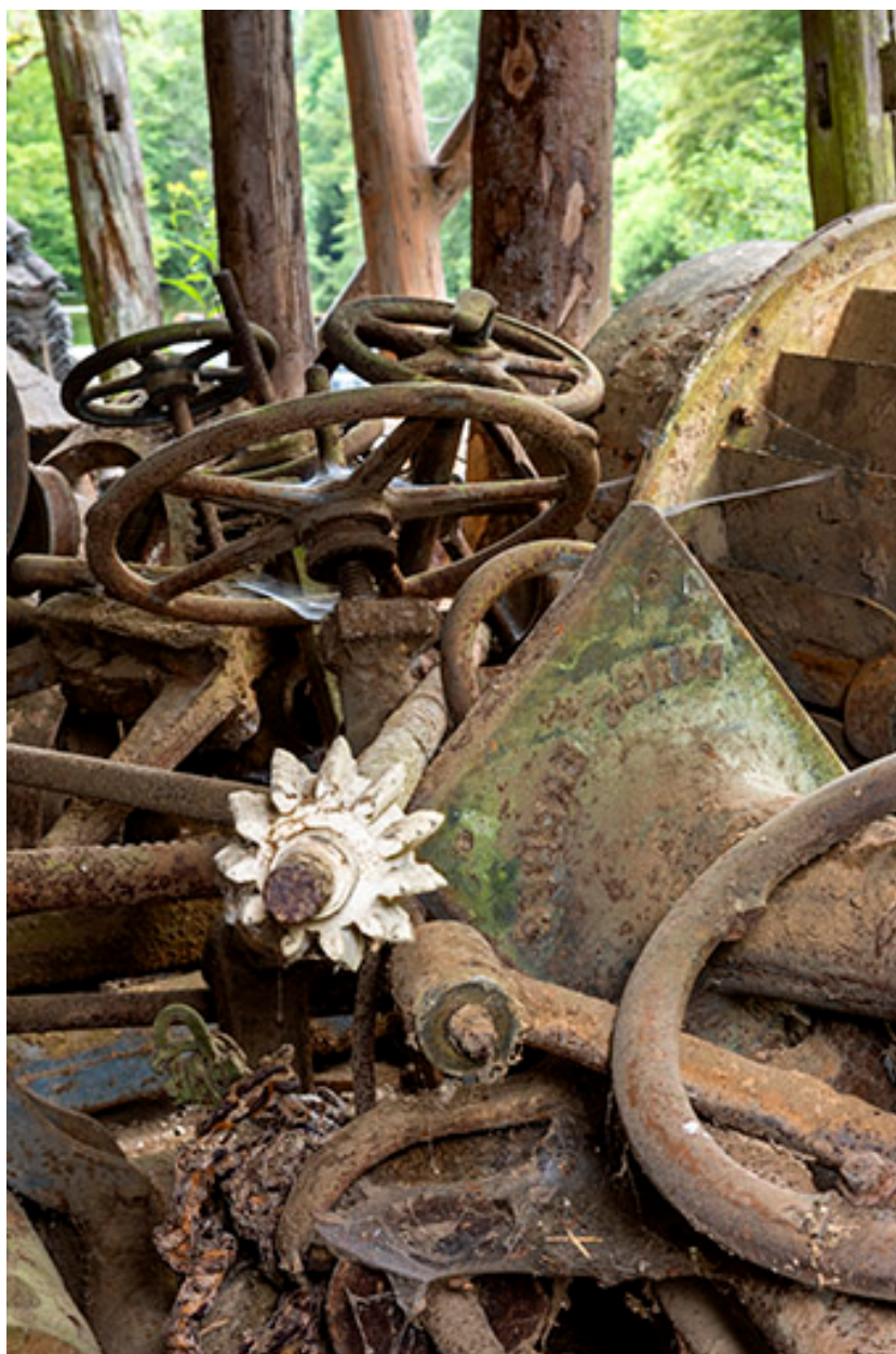
Eléments de l'installation de la scierie démontés.
