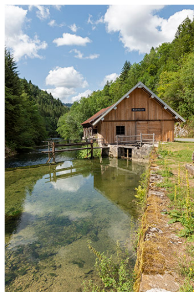
Scierie, depuis l'amont (sud). Phot. Sonia Dourlot IVR43_20192500705NUC4A
