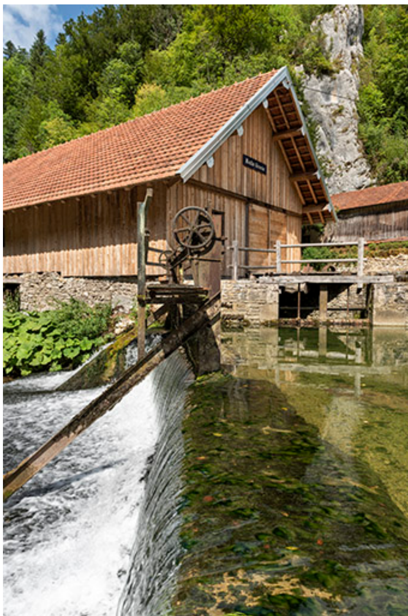
Barrage et vannes, depuis la rive gauche.
