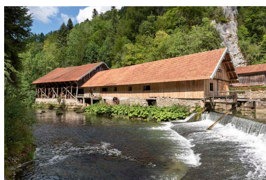
Hangar et scierie, depuis l'ouest (rive gauche). Phot. Sonia Dourlot IVR43_20192500707NUC4A
