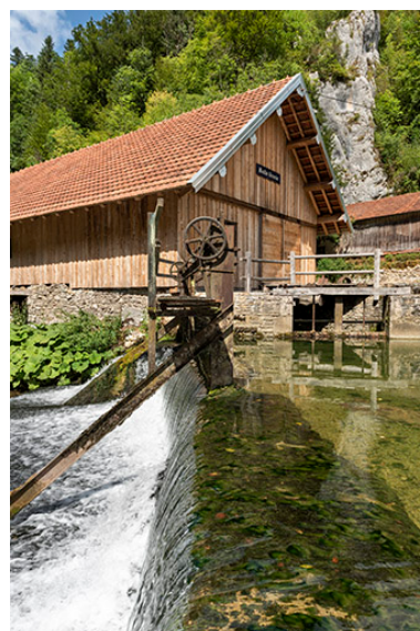
Barrage et vannes, depuis la rive gauche. Phot. Sonia Dourlot IVR43_20192500710NUC4A
