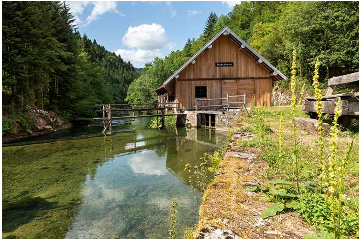
Scierie, depuis l'amont (sud) : vue rapprochée.
