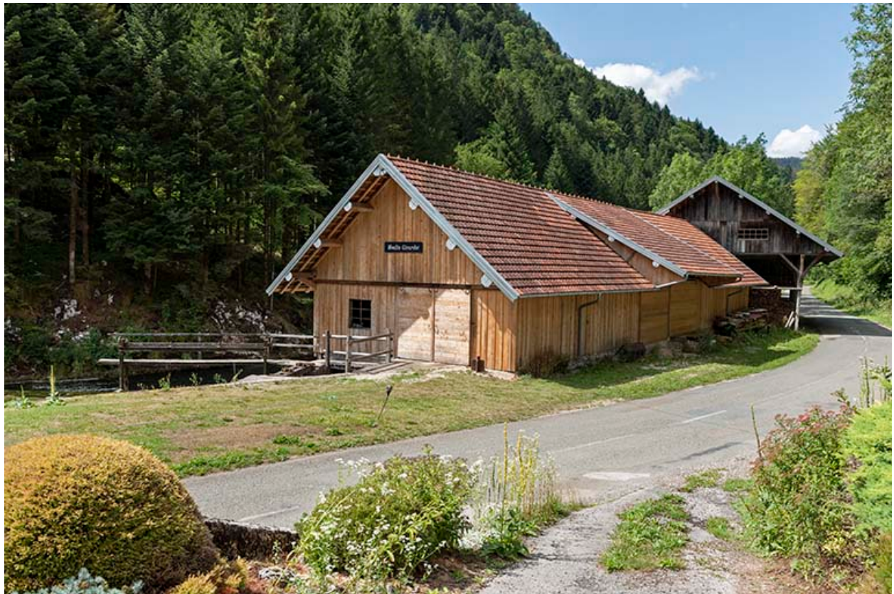
Hangar et scierie, depuis le sud-est.
