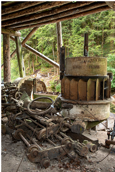
Turbine Douge et transmission démontées. Phot. Sonia Dourlot IVR43_20192500711NUC4A
