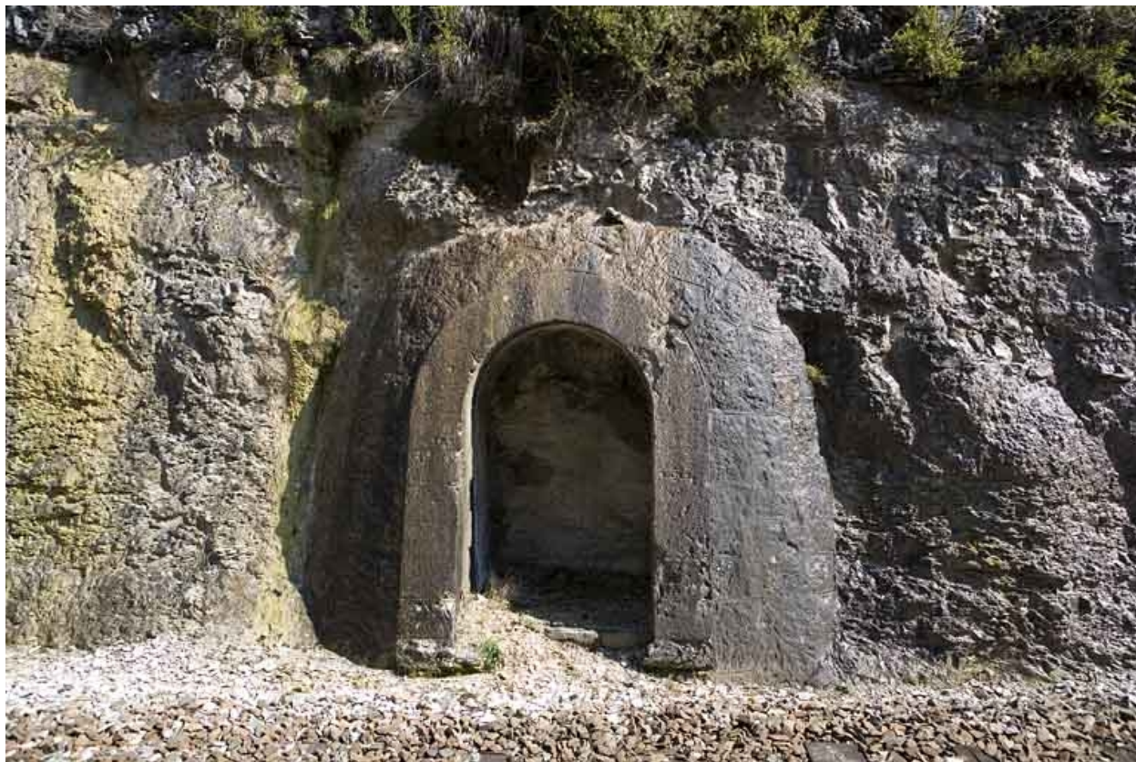
Cinquième abri (à gauche de la voie).
