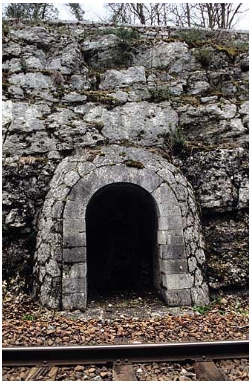
Deuxième abri (à droite de la voie).
