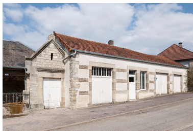
Vue d'ensemble. Phot. Jérôme Mongreville IVR43_20167000465NUC4A
