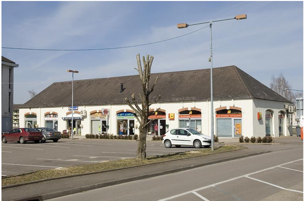
Atelier de fabrication (machines-outils). Façade sud.
