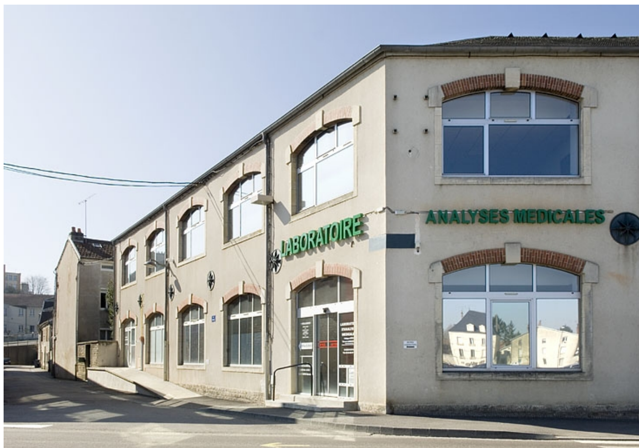
Atelier de fabrication (peinture). Façade est.
