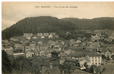
1236. Maîche - Vue prise du clocher [centre du village et quartier de Montjoie], 2e quart 20e siècle. Autr. Charles Simon IVR43_20152502031NUC4A
