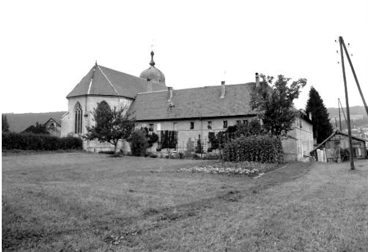
Extérieur : façade est.
