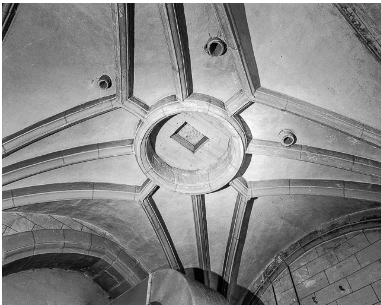
Détail de la voûte.
