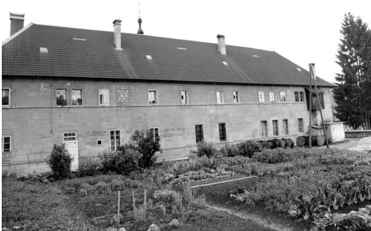
Extérieur : façade sud.
