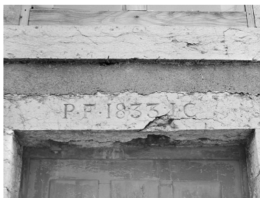
Date sur la porte ouvrant sur la rue Charles-Surleau. Phot. Jérôme Mongreville IVR43_19872500844X
