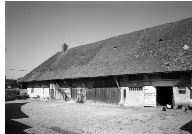
Dépendances et logis sous le même toit. Phot. Michel Rosso IVR26_19852101589V
