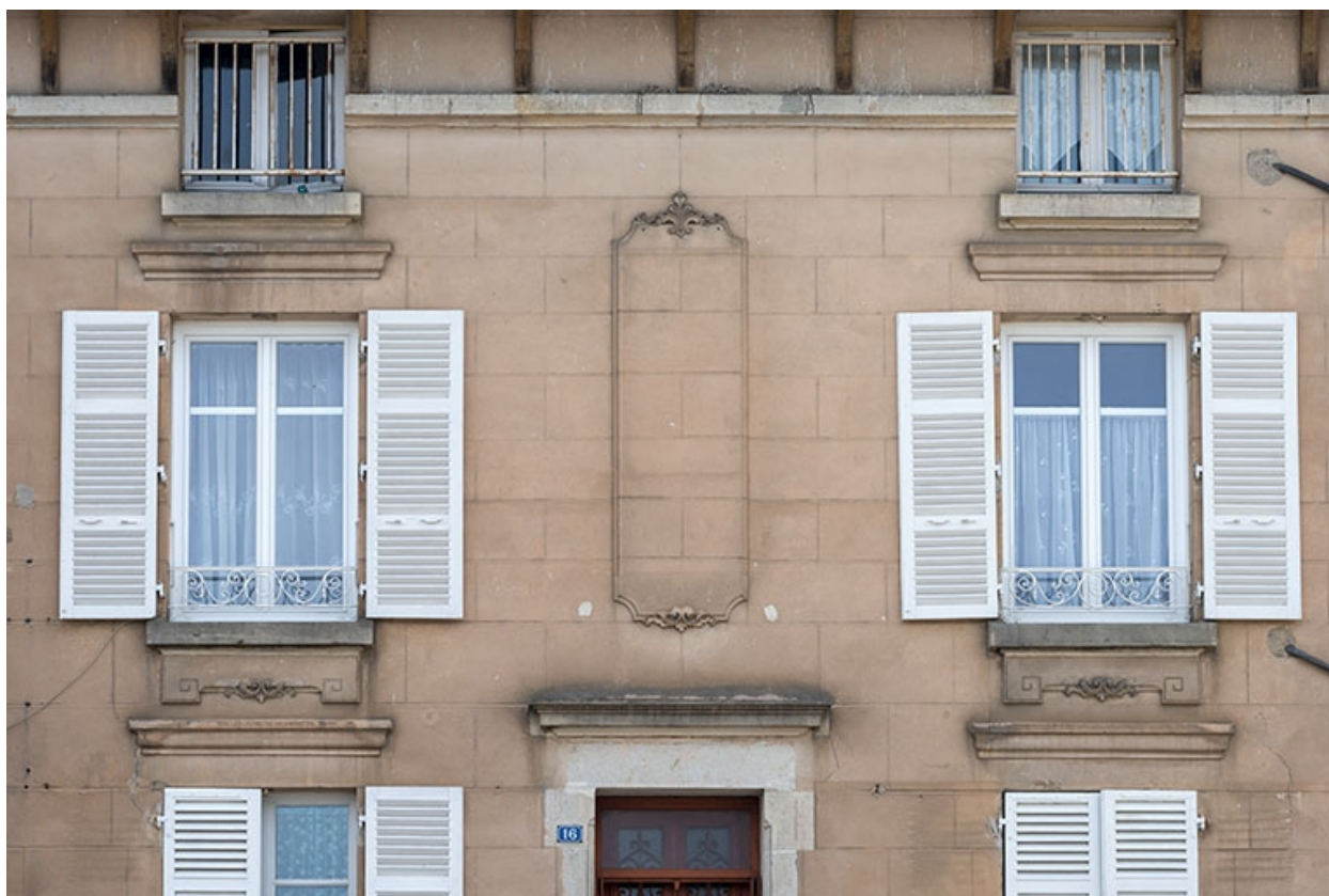
Détail de la façade sur rue.
