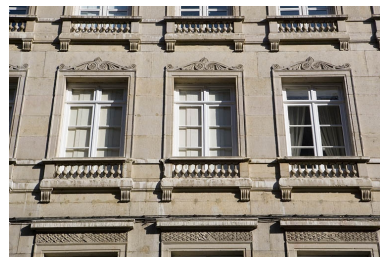
Détail des fenêtres du premier étage. Phot. Yves Sancey IVR43_20082500247NUC2A
