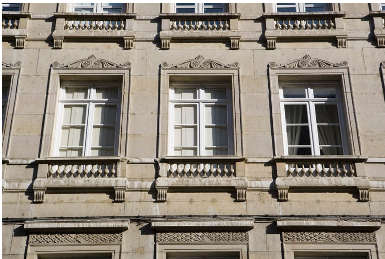
Détail des fenêtres du premier étage.
