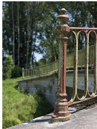
Détail du garde-corps en métal. Phot. Thierry Kuntz IVR26_20112103236NUC4A
