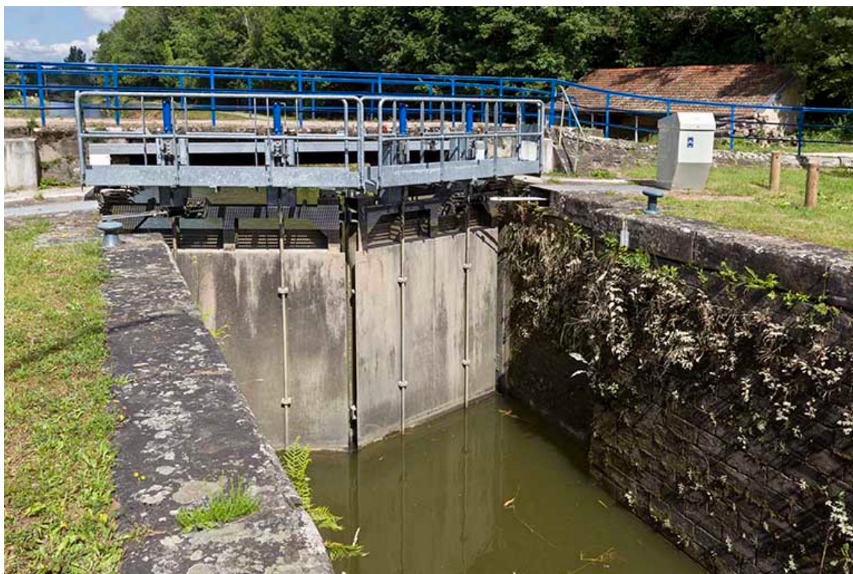
Les portes de l'écluse, busquées vers l'amont.
