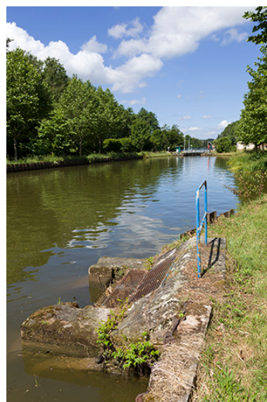
Déversoir. Phot. Sonia Dourlot IVR43_20157000933NUC2A
