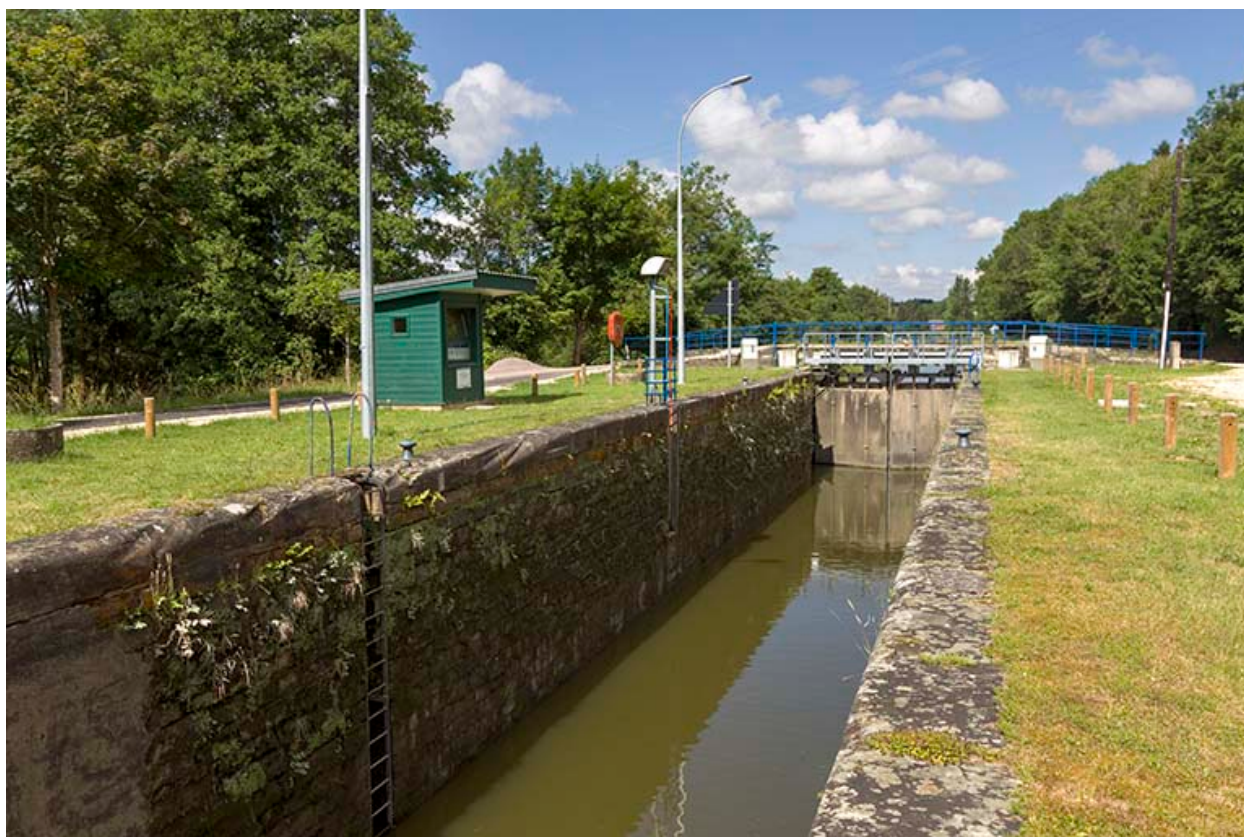
L'écluse et son poste de commande.
