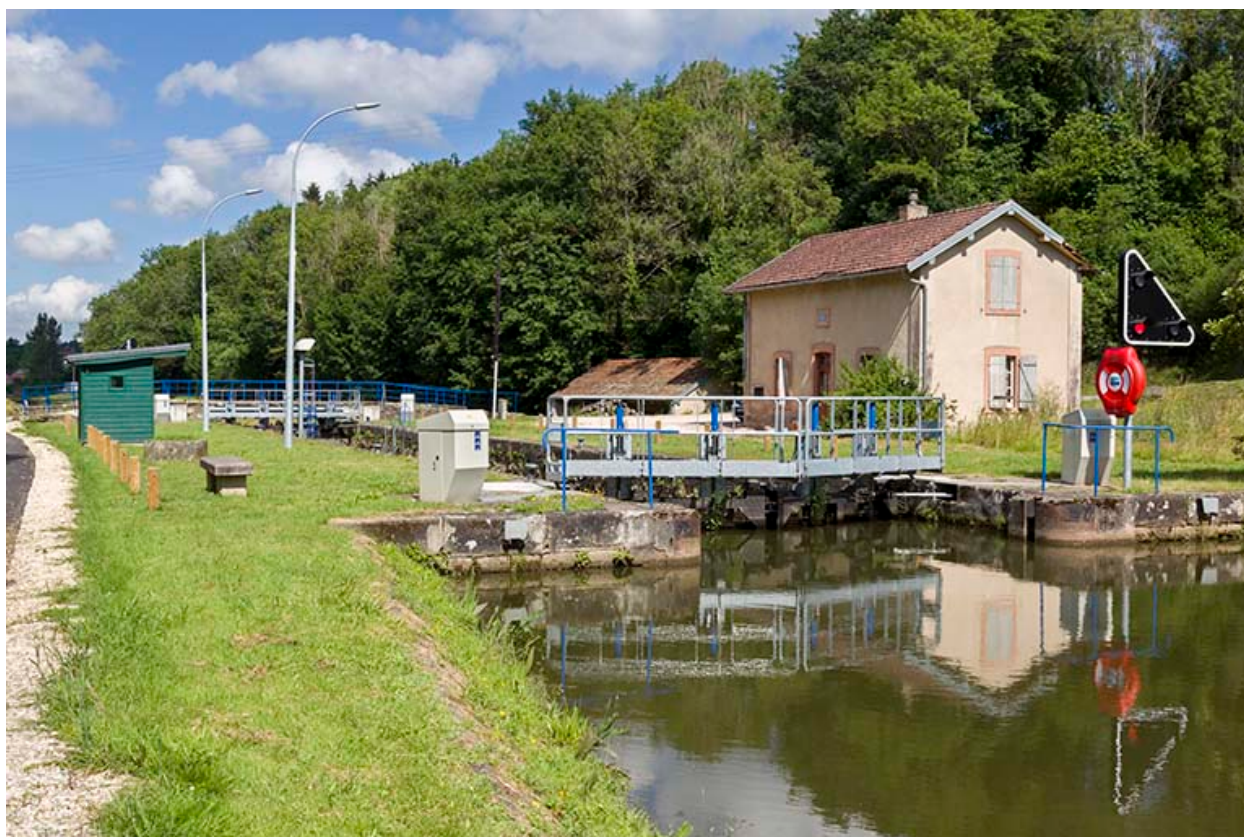
Le site d'écluse, depuis l'amont.
