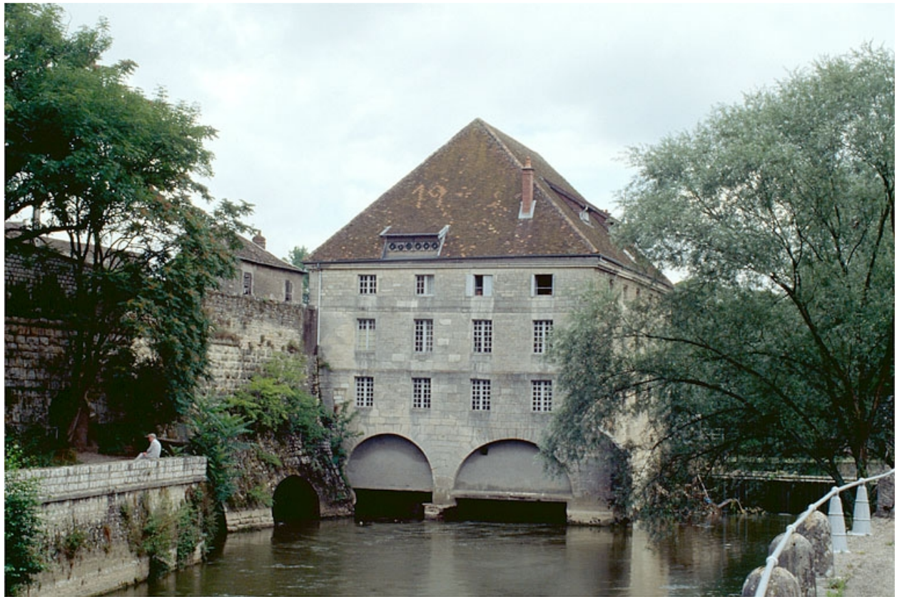
Ancien moulin vu de l'aval.
