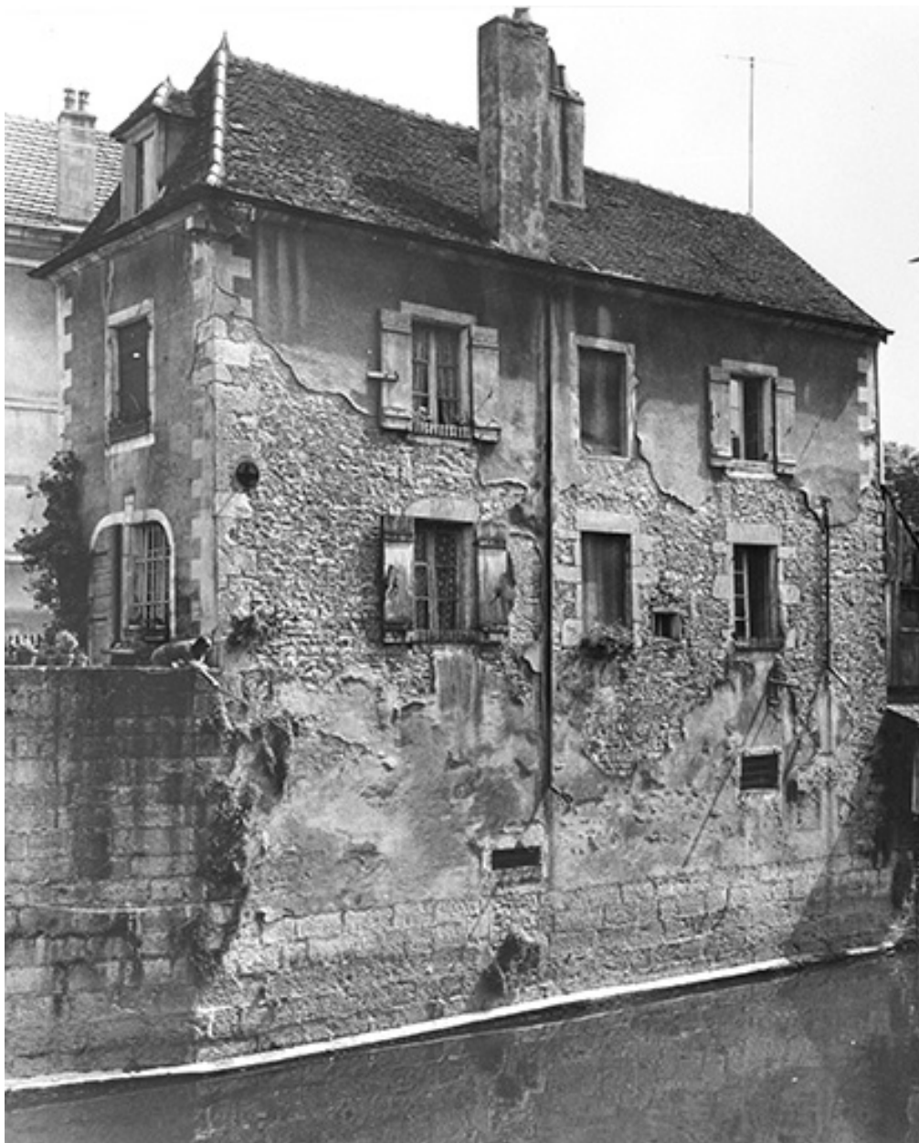
Façade postérieure de la maison datée 1780.
