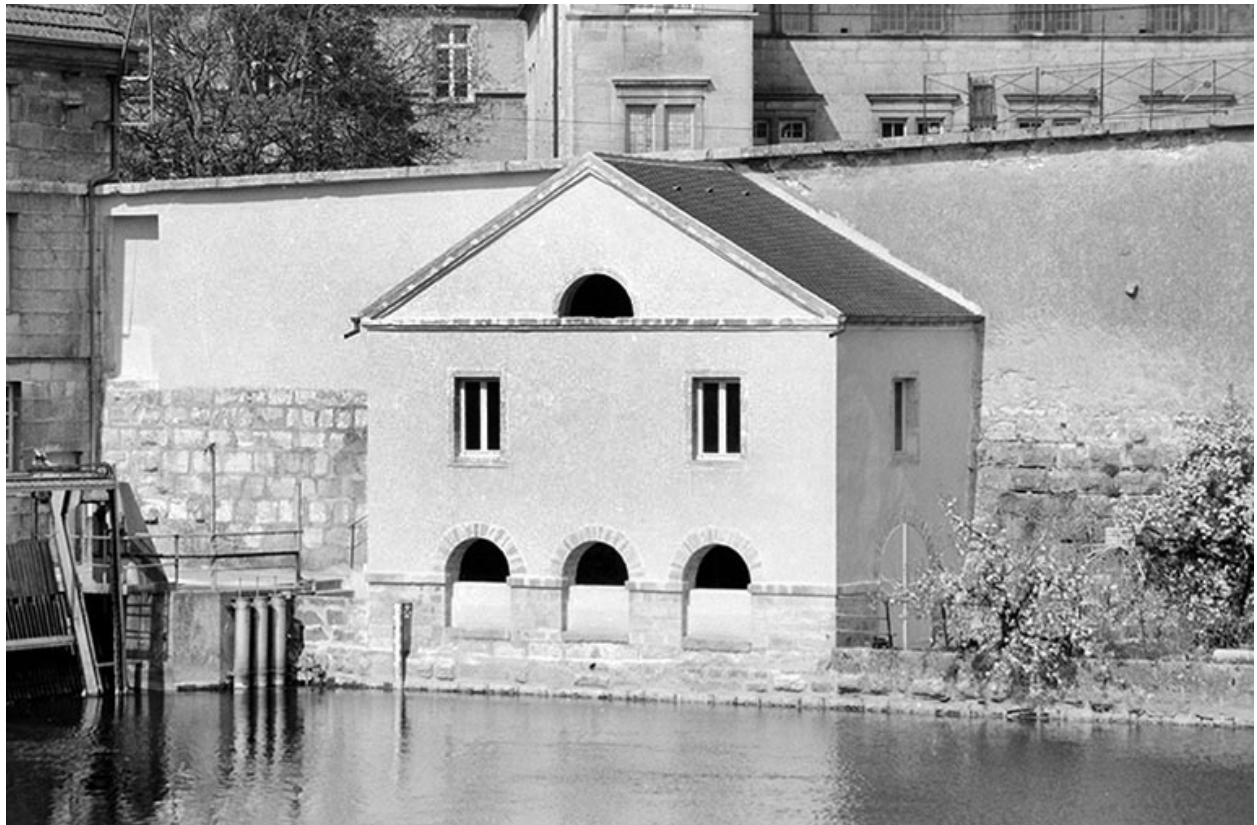
Logement du fontainier en 1990.
