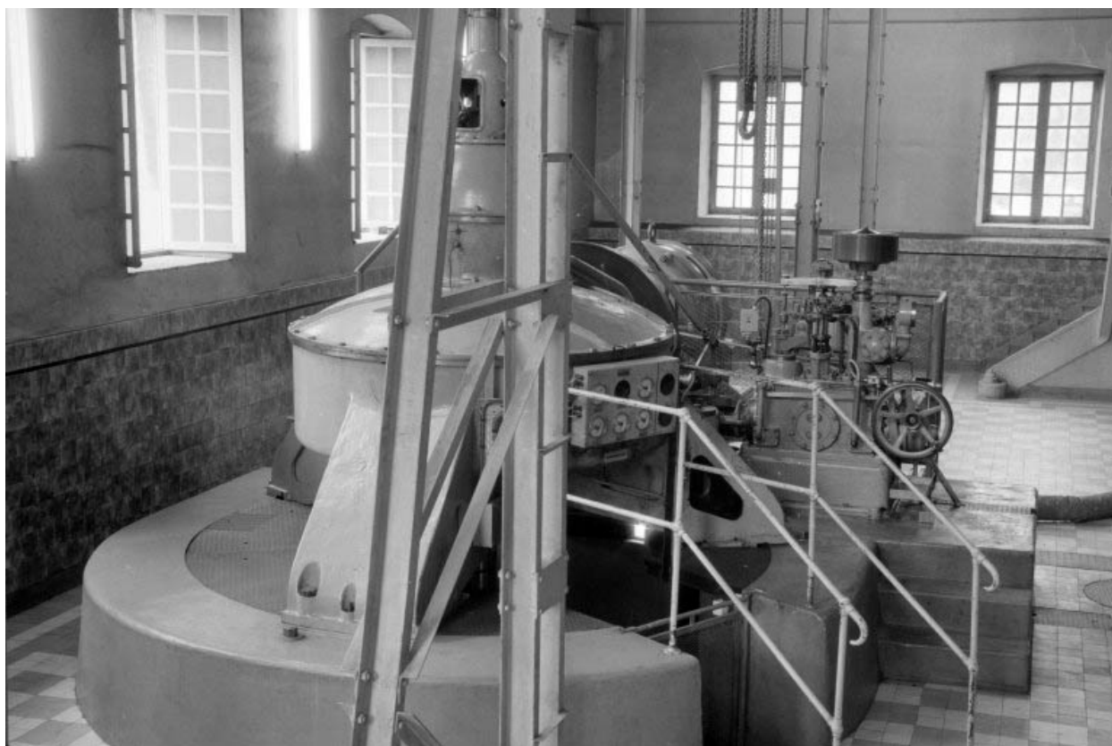
Multiplicateur et régulateur d'admission d'eau de la turbine Neyrpic. Multiplicateur Messian, régulateur à boules Neyrpic (modèle 1924 modifié 1927).
