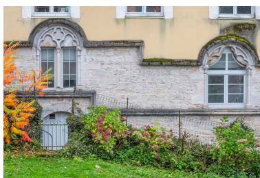
Fenêtres de la façade nord. Phot. Jérôme Mongreville IVR43_20243901021NUC4A
