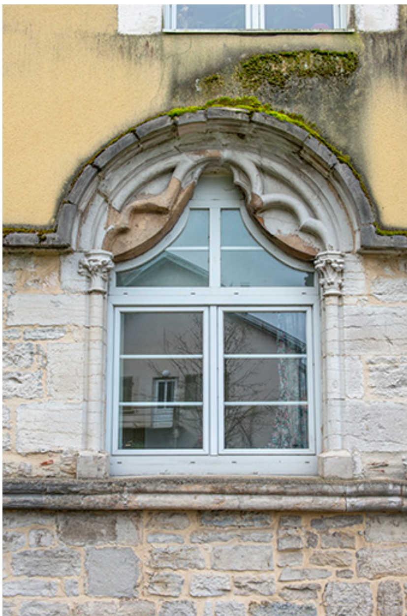
Façade nord. Détail de la fenêtre droite.
