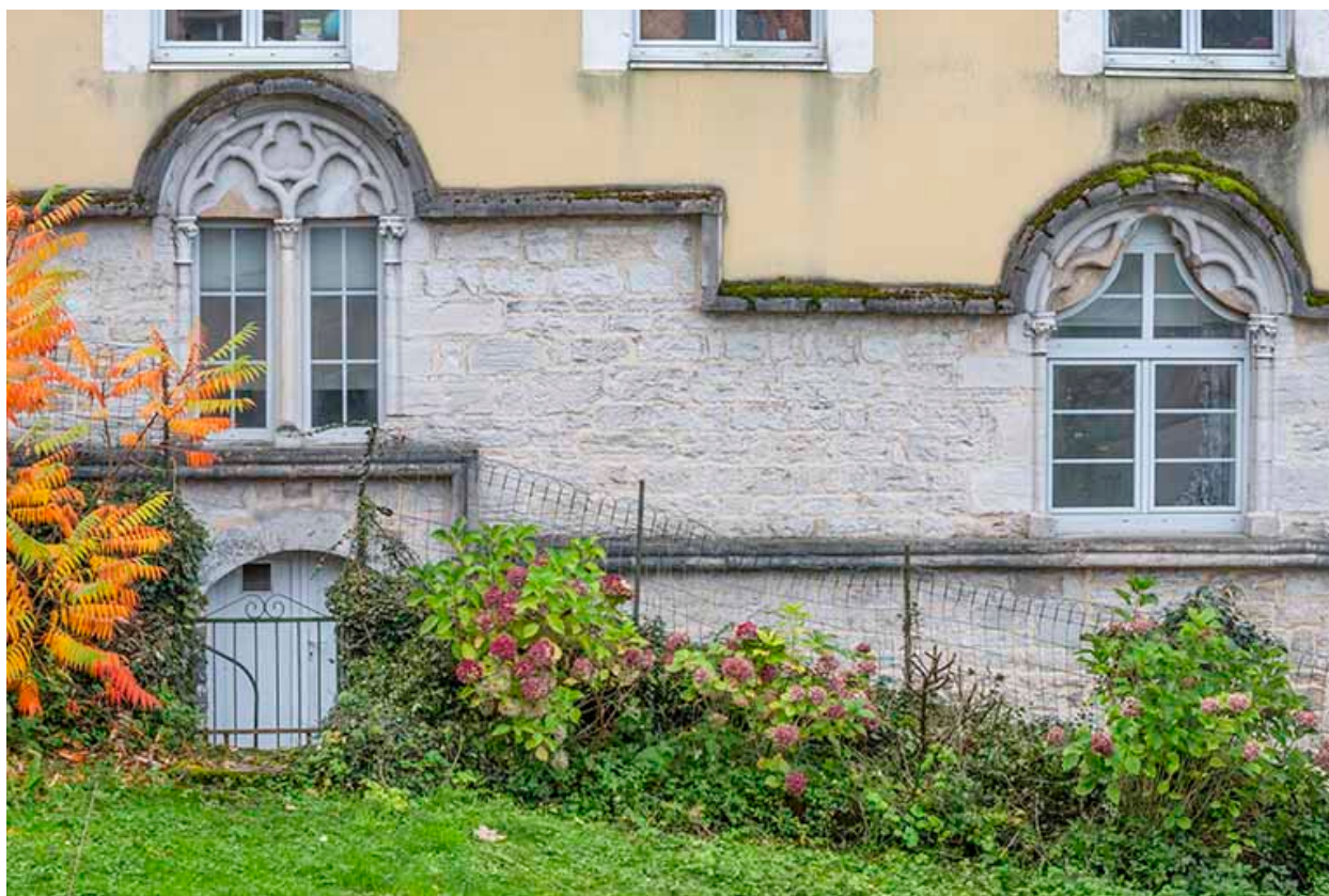
Fenêtres de la façade nord.
