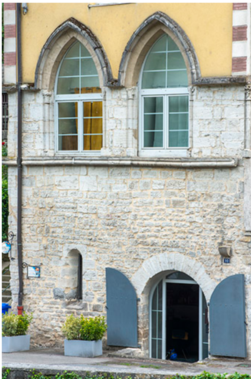
Façade ouest, vue de trois quarts droite.
