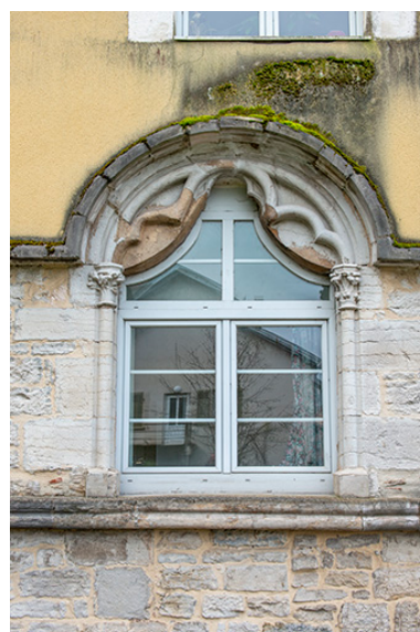
Façade nord. Détail de la fenêtre droite. Phot. Jérôme Mongreville IVR43_20243901025NUC4A
