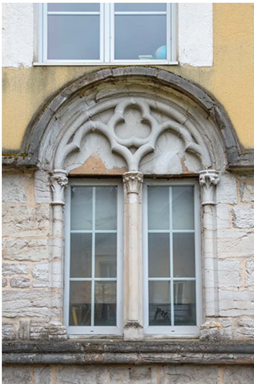
Façade nord. Détail de la fenêtre gauche.
