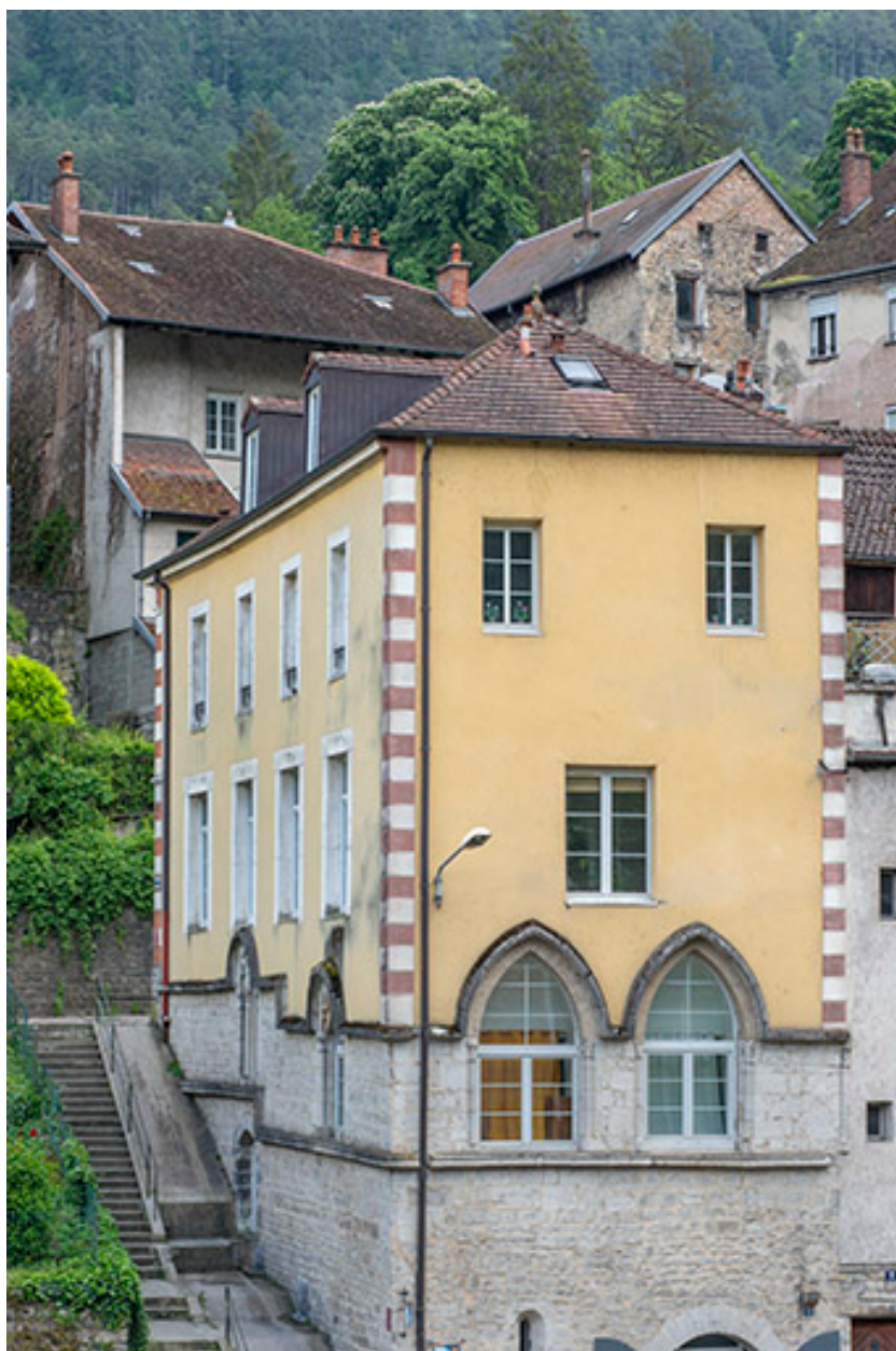
Partie supérieure, depuis l'ouest.
