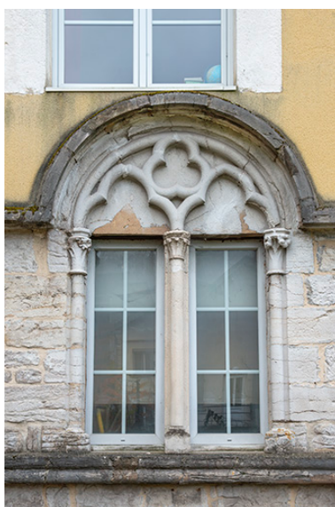
Façade nord. Détail de la fenêtre gauche. Phot. Jérôme Mongreville IVR43_20243901024NUC4A
