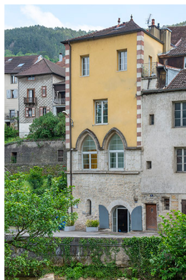
Elévation de la façade ouest. Phot. Jérôme Mongreville IVR43_20233900461NUC4A
