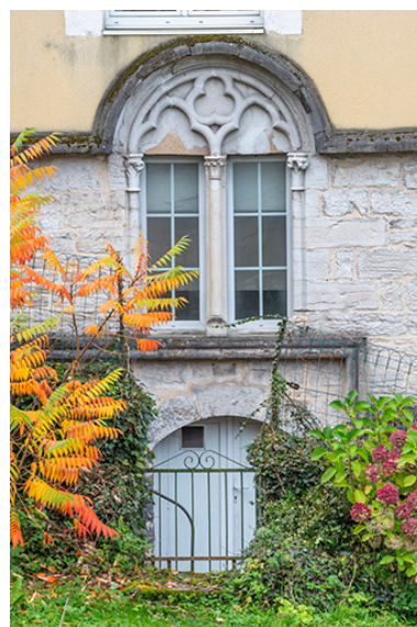
Façade nord. Fenêtre en plein- cintre, à remplage et colonnettes. Phot. Jérôme Mongreville IVR43_20243901022NUC4A
