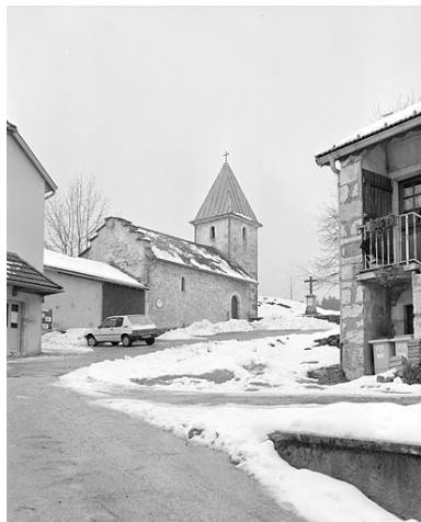
Vue générale depuis le nord-est. Phot. Yves Sancey IVR43_19963901821X
