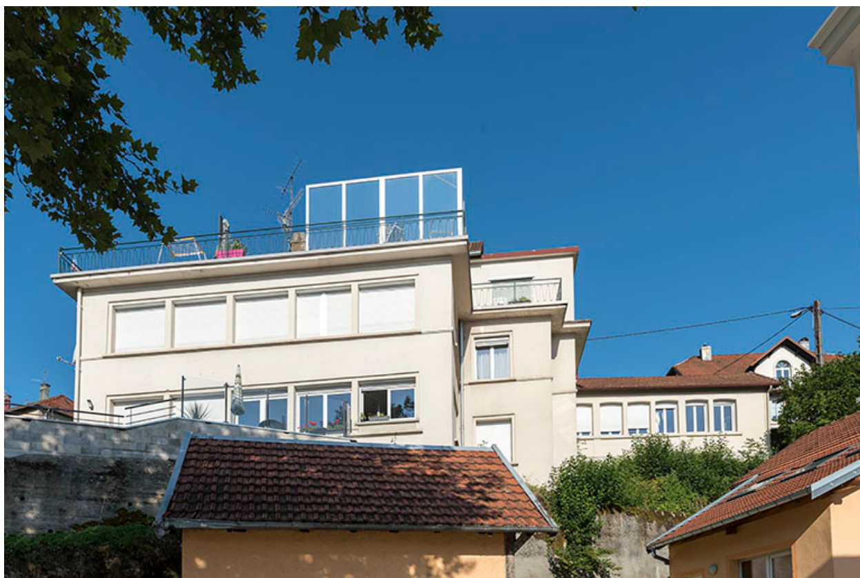
Façade postérieure, vue en contre-plongée.
