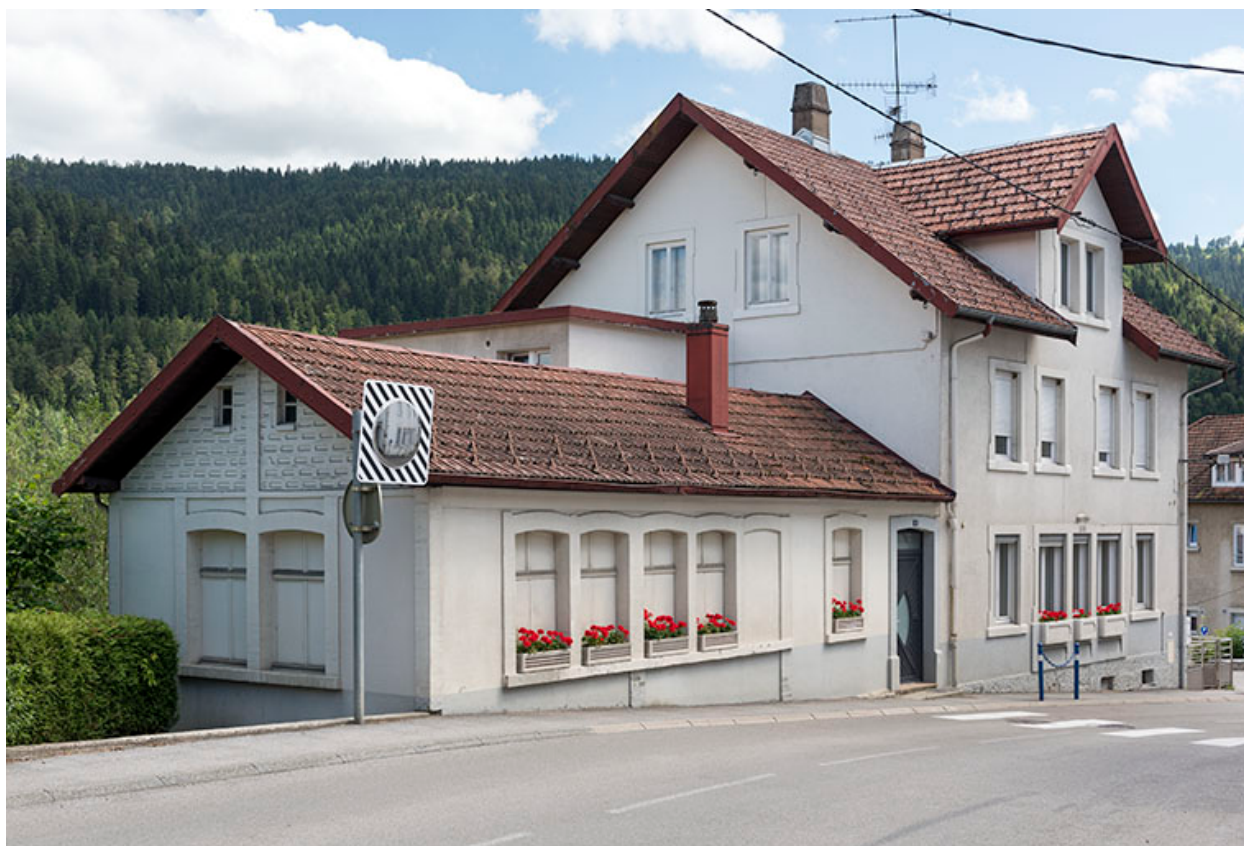
Façades antérieure et latérale gauche.
