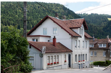
Vue d'ensemble, depuis le nord. Phot. Sonia Dourlot IVR43_20162500845NUC4A
