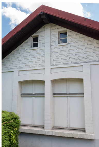
Atelier de fabrication de 1905 environ : mur pignon, avec fenêtre horlogère et briques silico-calcaires.
