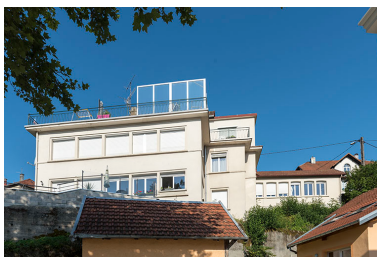
Façade postérieure, vue en contre-plongée.
