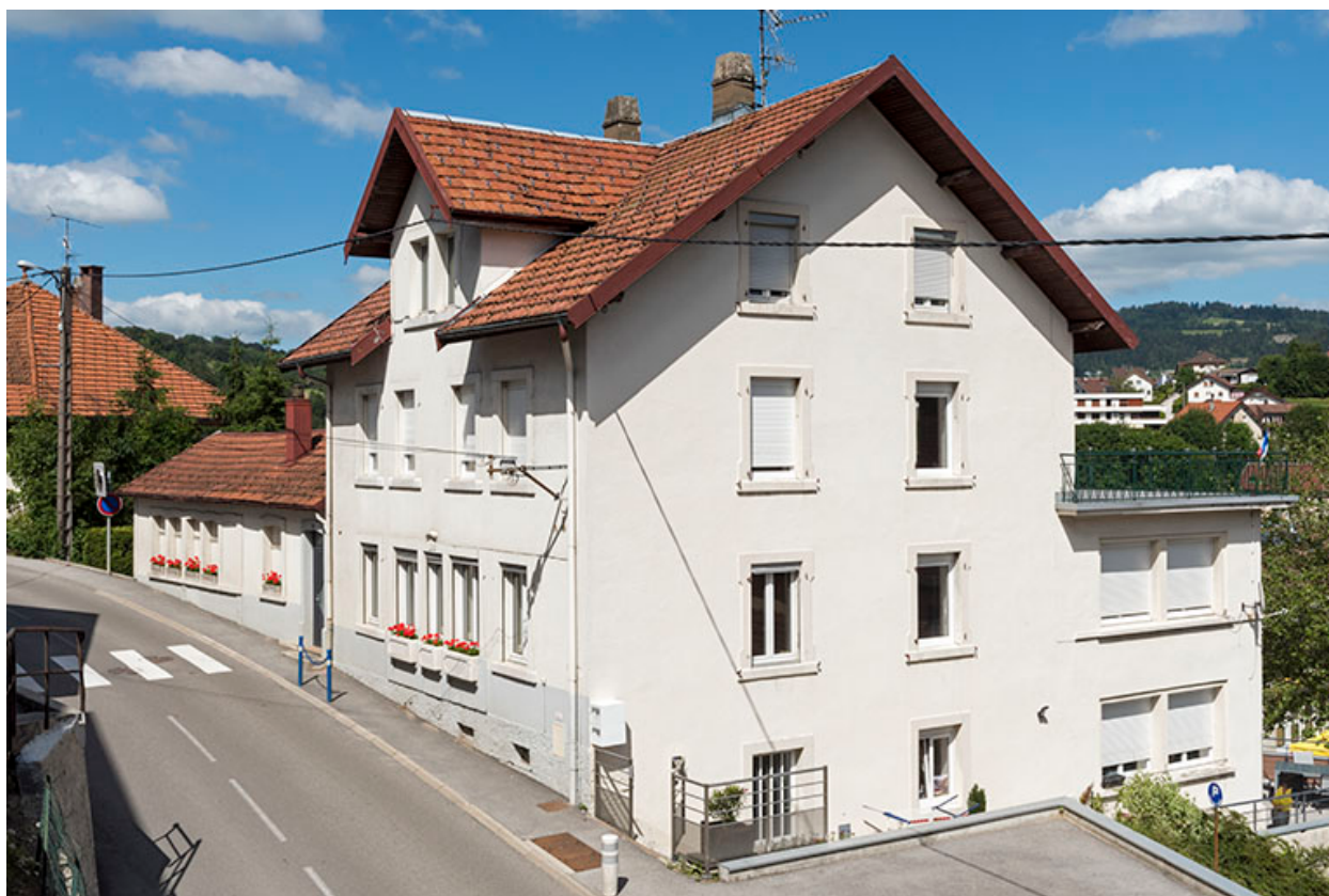
Façades antérieure et latérale droite.
