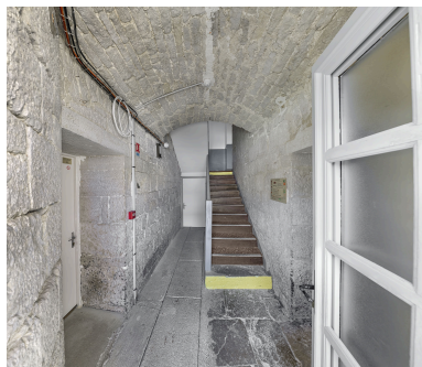
Caserne U, rez-de-chaussée : cage d'escalier. Phot. Thierry Kuntz IVR43_20213900390NUC4A
