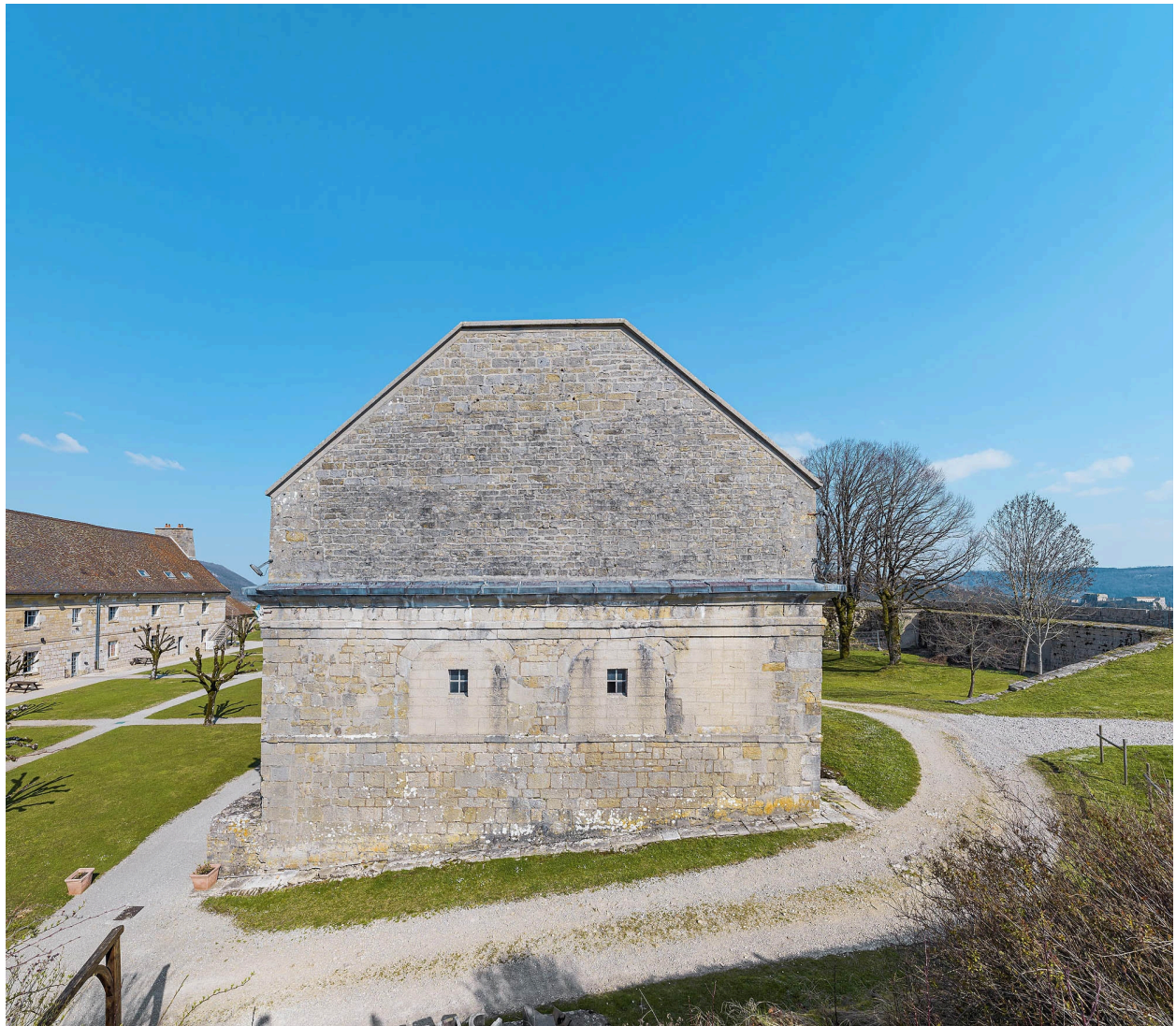
Caserne V : Mur pignon.
