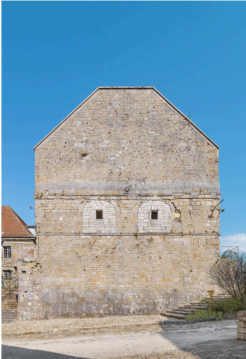
Caserne U : mur pignon épaissi, au cours du 19e siècle pour être à l'épreuve des bombes.
