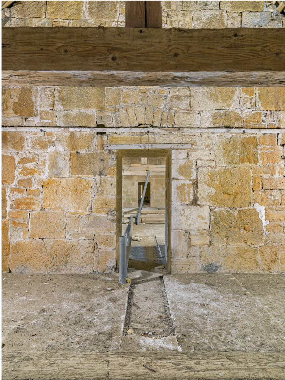
Caserne U, grenier : vue traversante.
