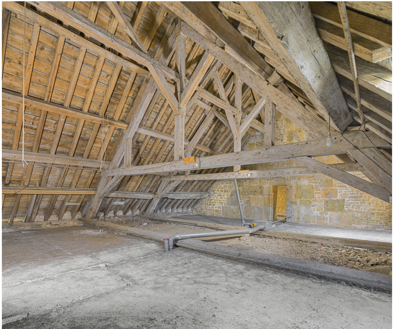
Caserne U, grenier : charpente du bâtiment.
