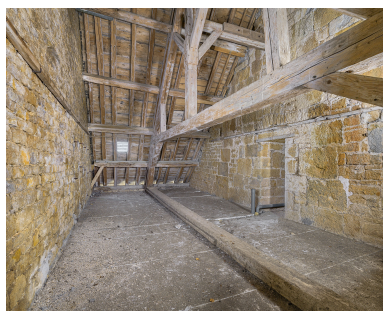
Caserne U, grenier : vue générale d'une ferme composant la charpente. Phot. Thierry Kuntz IVR43_20213900398NUC4A
