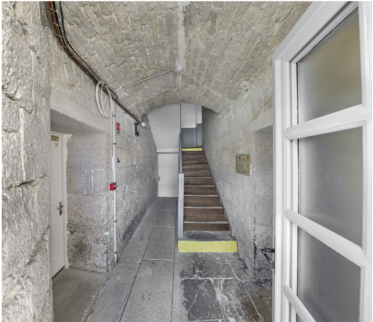
Caserne U, rez-de-chaussée : cage d'escalier.
