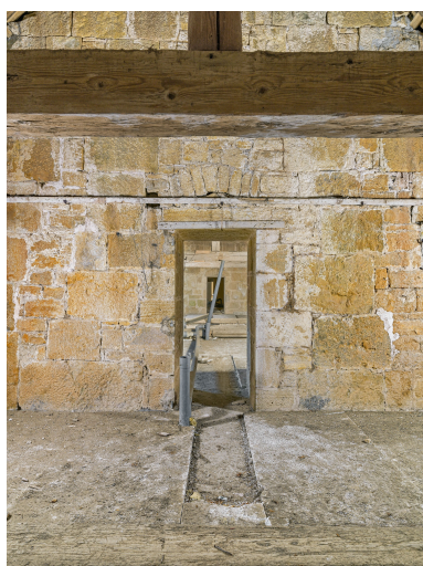
Caserne U, grenier : vue traversante. Phot. Thierry Kuntz IVR43_20213900393NUC4A
