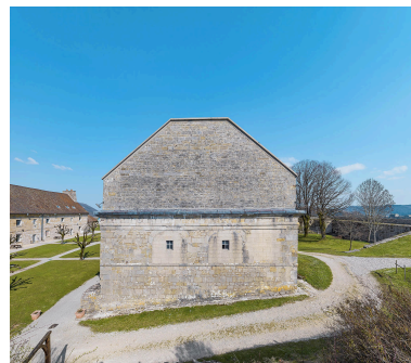
Caserne V : Mur pignon. Phot. Thierry Kuntz IVR43_20223900550NUC4A
