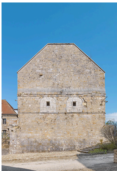
Caserne U : mur pignon épaissi, au cours du 19e siècle pour être à l'épreuve des bombes. Phot. Thierry Kuntz IVR43_20223900559NUC4A
