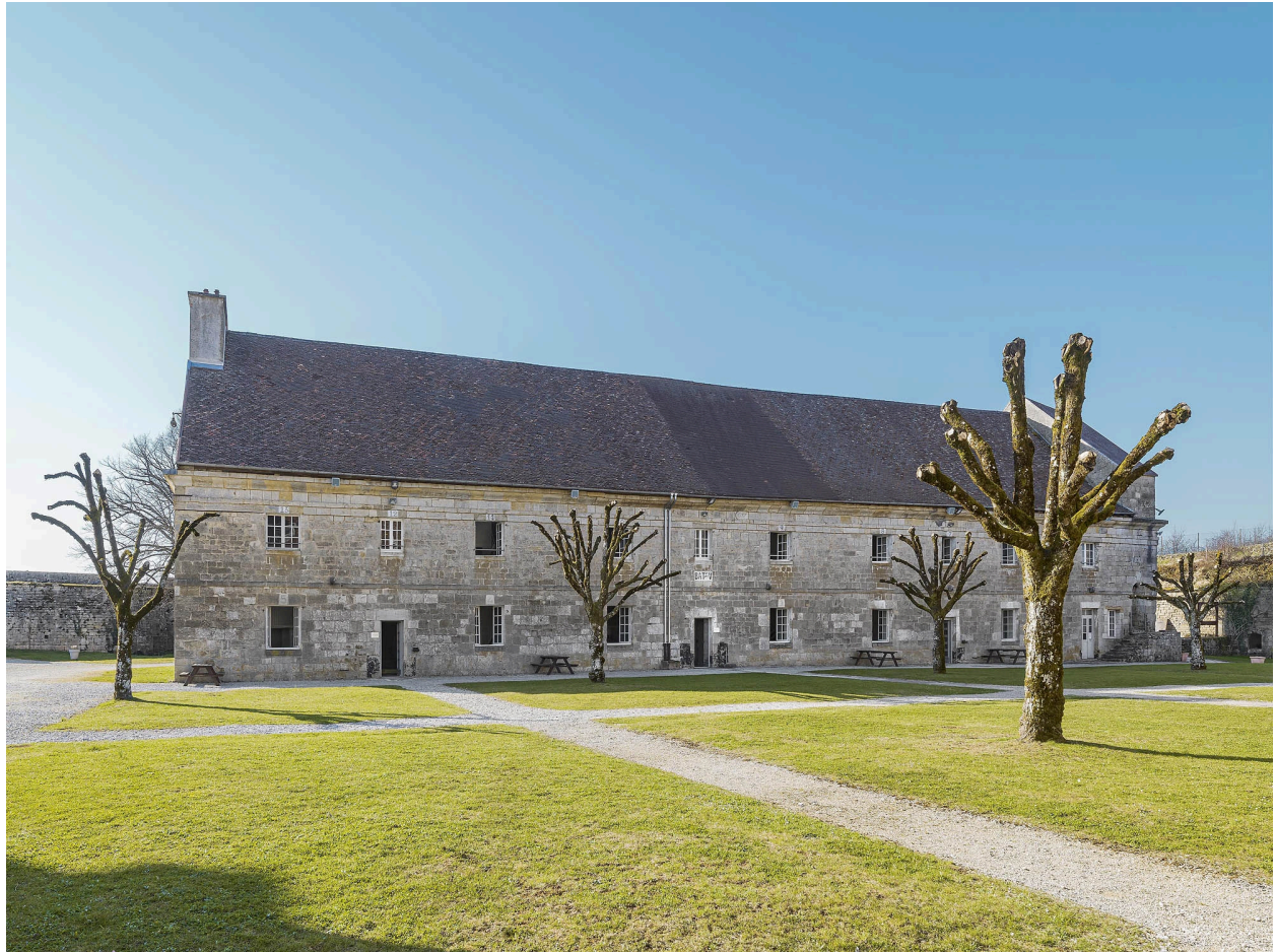
Caserne V : façade antérieure.
