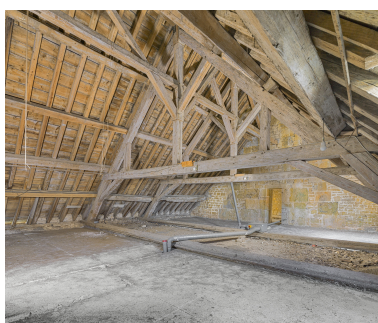
Caserne U, grenier : charpente du bâtiment. Phot. Thierry Kuntz IVR43_20213900394NUC4A
