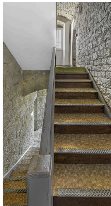
Caserne U : escalier tournant vers l'étage carré. Phot. Thierry Kuntz IVR43_20213900392NUC4A
