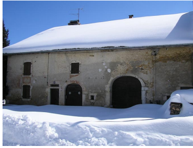
Vue générale de la façade antérieure.
