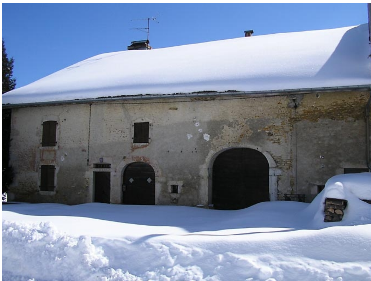
Vue générale de la façade antérieure.
