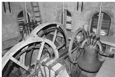
Vue d'ensemble du beffroi de charpente et de la 3e cloche. Phot. Jérôme Mongreville IVR43_20003900778Z
