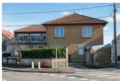
Façades nord. Phot. Jérôme Mongreville IVR43_20182500562NUC4A
