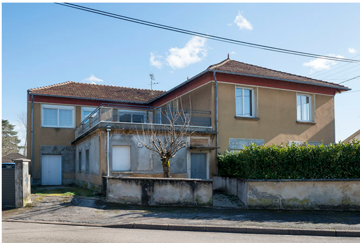
Vue depuis le nord.
