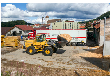
Silos à copeaux (B) : chargement d'un camion.
