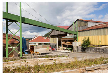
Ateliers de triage et d'empilage (G, F, E), de trois quarts droite. Le tapis roulant d'amenée de la sicure et des copeaux enjambe la voie. Phot. Yves Sancey IVR43_20132501717NUC2A
