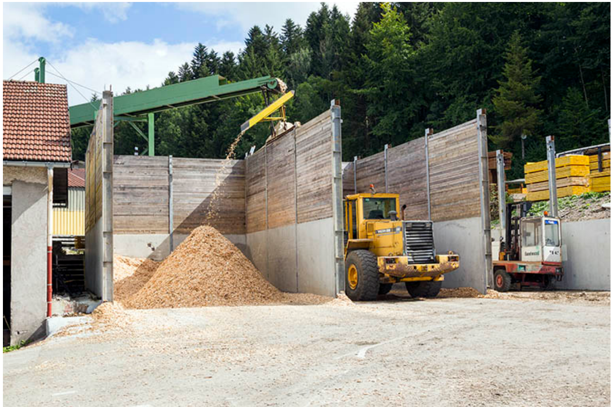
Silos à copeaux (B).
