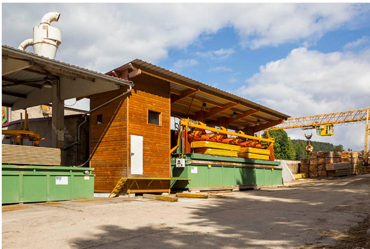
Atelier de trempage (J).
