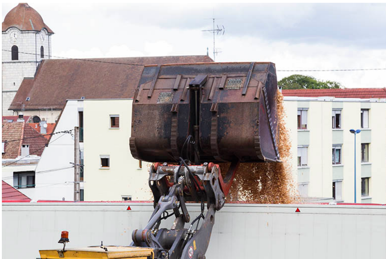
Silos à copeaux (B) : godet du chargeur.
