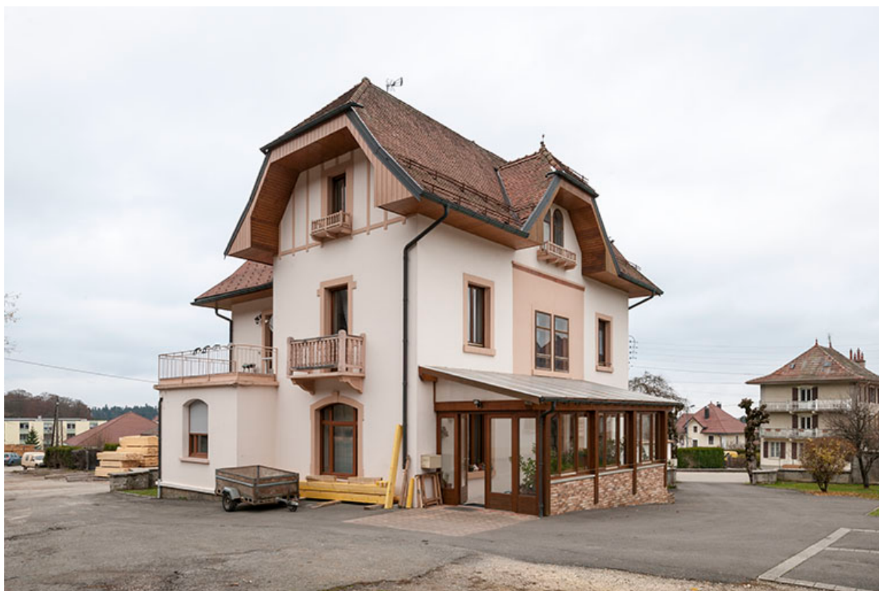
Logement patronal : façades sud et est.
