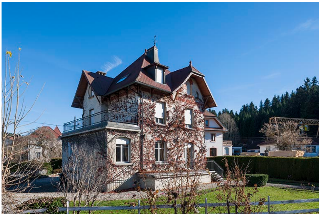
Villa Mascotte : façades postérieure et latérale droite.
