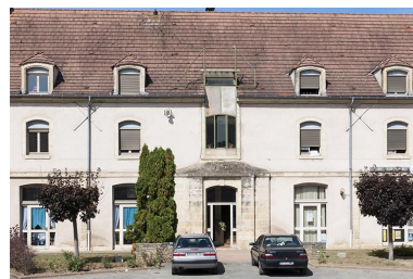
Façade antérieure : le corps central. Phot. Jérôme Mongreville IVR43_20127000729NUC4A
