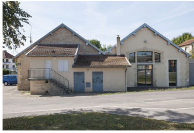
Vue d'ensemble des deux anciennes écuries. Phot. Jérôme Mongreville IVR43_20127000731NUC4A
