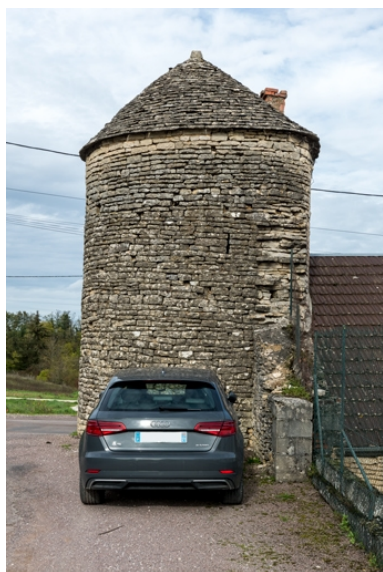
Vue de la tour depuis le sud. Phot. Pierre-Marie Barbe-Richaud IVR26_20222100981NUC2A
