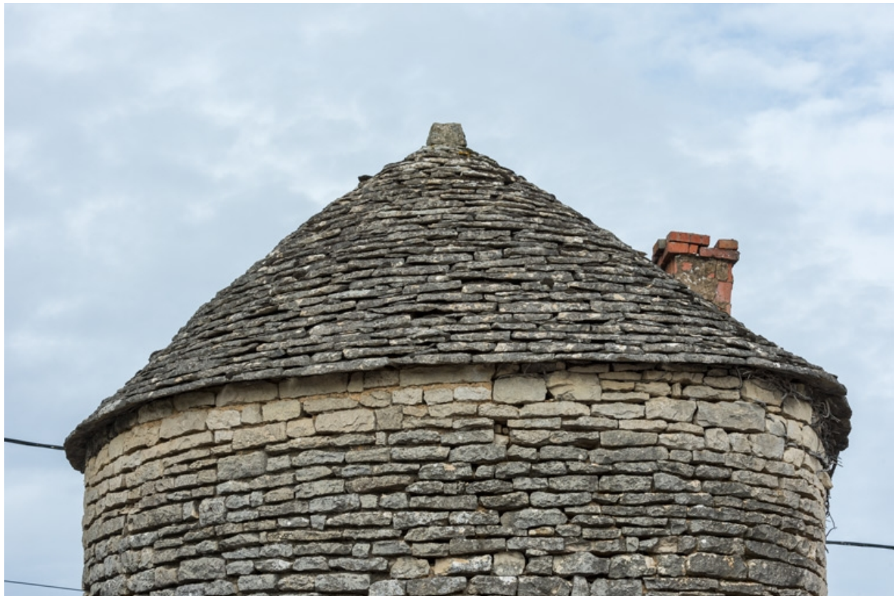
Détail de la toiture.
