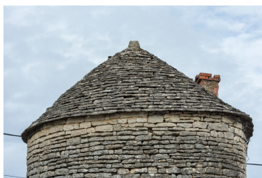
Détail de la toiture. Phot. Pierre-Marie Barbe-Richaud IVR26_20222100982NUC4A
