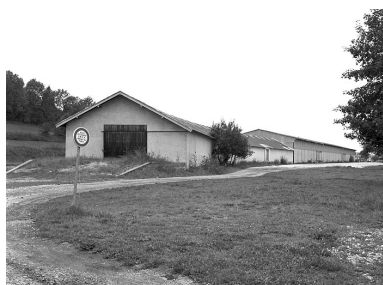
Entrepôts, depuis le sud-est.
