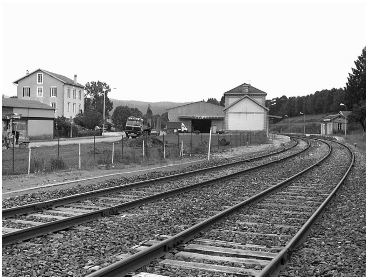
Vue d'ensemble, depuis le nord (côté Andelot-en-Montagne).
