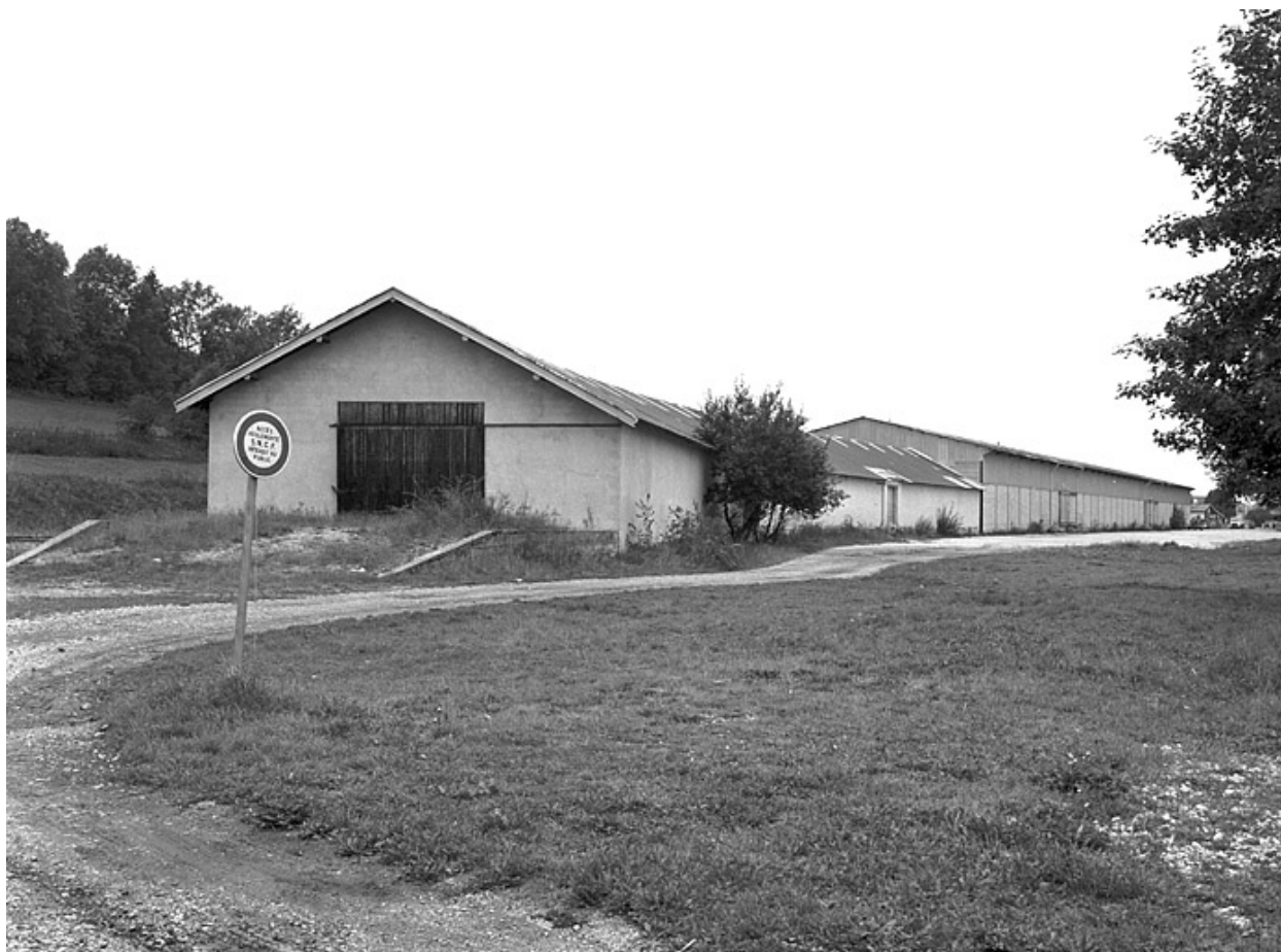
Entrepôts, depuis le sud-est.
