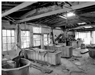
Intérieur de l'atelier de teinture (bâtiment P). Phot. Yves Sancey IVR43_19943901571X
