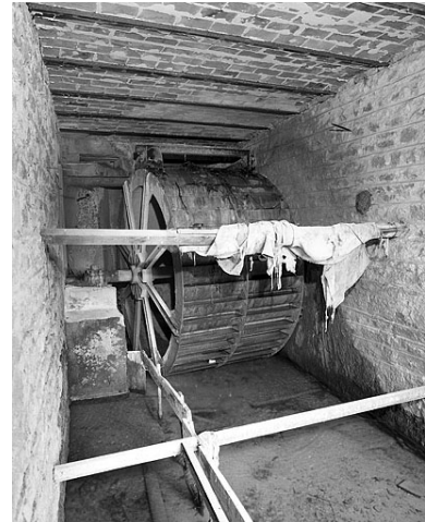
Petite roue hydraulique. Phot. Yves Sancey IVR43_19943901564X
