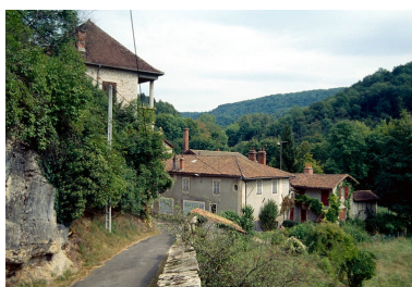
Logements vus de l'ouest. Phot. Laurent Poupard IVR43_19933900466ZA
