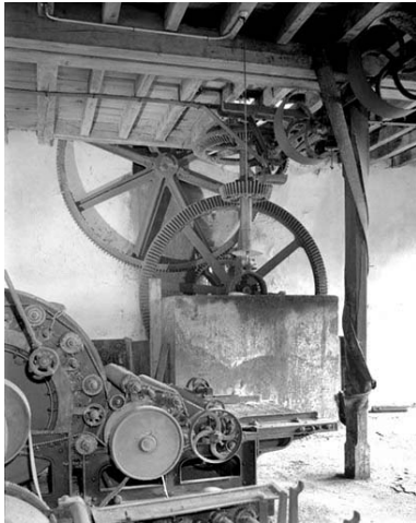
Transmission de la grande roue hydraulique. Phot. Yves Sancey IVR43_19943901562X
