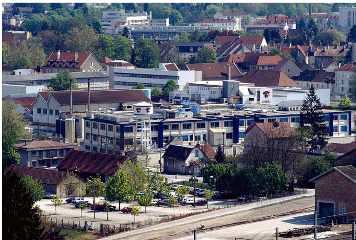
Vue d'ensemble depuis la côte de Montciel.
