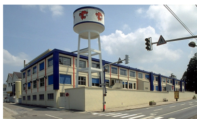
Atelier de fabrication depuis l'est. Phot. Jérôme Mongreville IVR43_19963900624ZA
