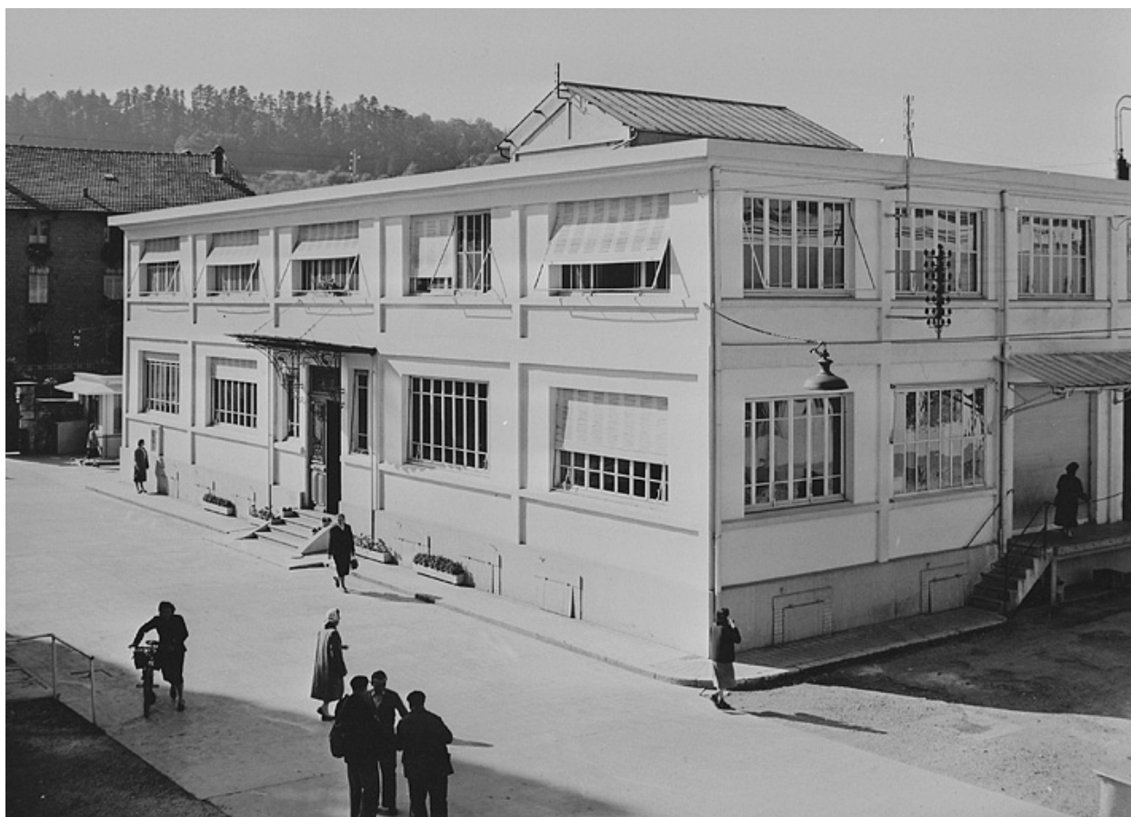
[Entrée de l'usine Bel].
