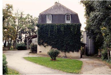
Façade latérale depuis le nord. Phot. Jérôme Mongreville IVR43_19953900448ZA
