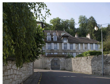
Vue d'ensemble depuis la rue.
