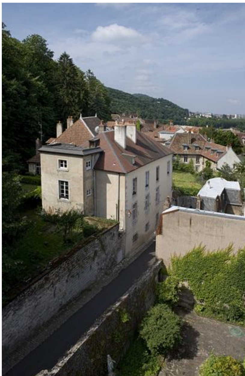
Vue d'ensemble depuis les locaux du CRDP.
