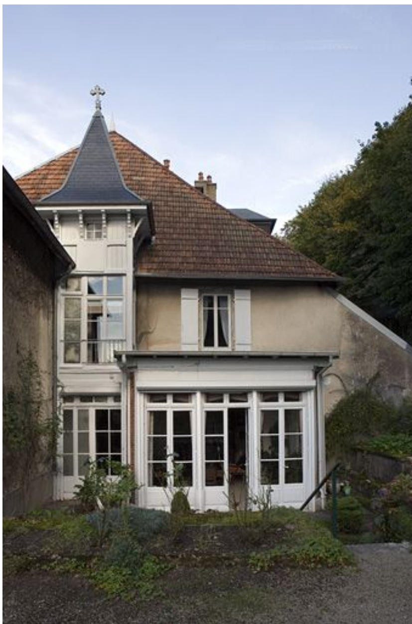
Façade latérale droite : vue rapprochée de face.
