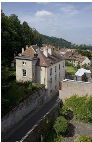
Vue d'ensemble depuis les locaux du CRDP.
