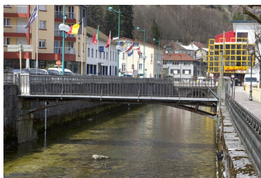
Passerelle aval, vue de l'amont. Phot. Yves Sancey IVR43_20103900172NUC2A
