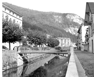
Passerelle amont, vue de l'amont. Phot. Yves Sancey IVR43_20033900692X
