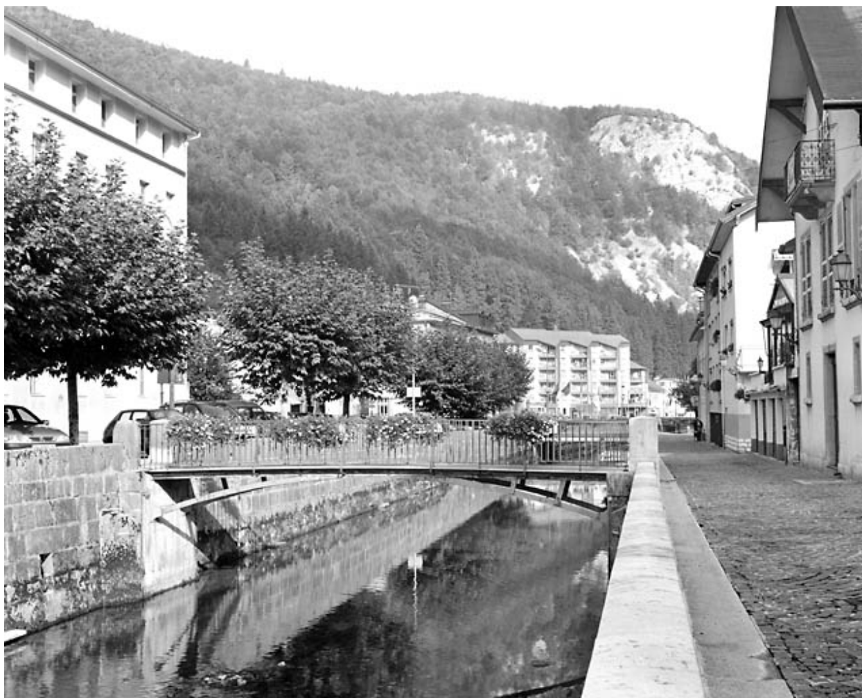
Passerelle amont, vue de l'amont.
