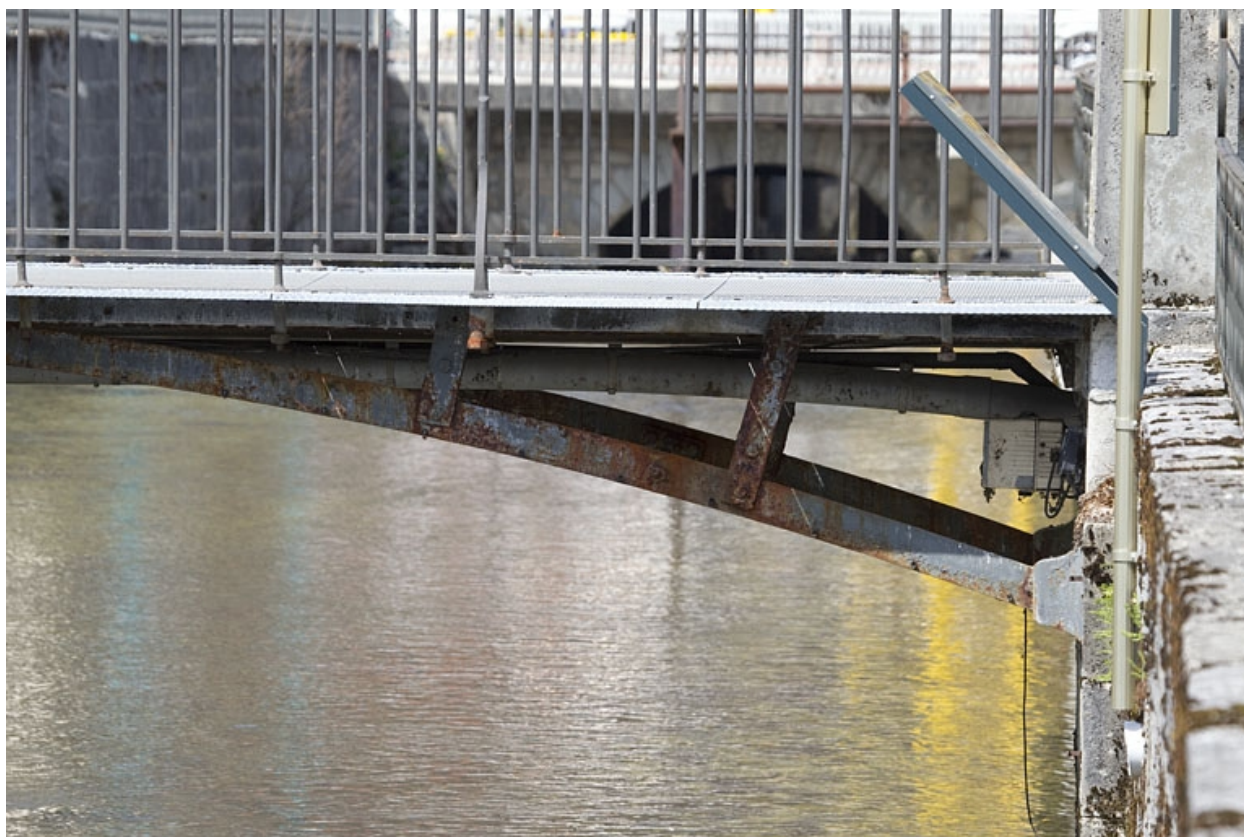
Passerelle aval : détail de l'extrémité rive droite.
