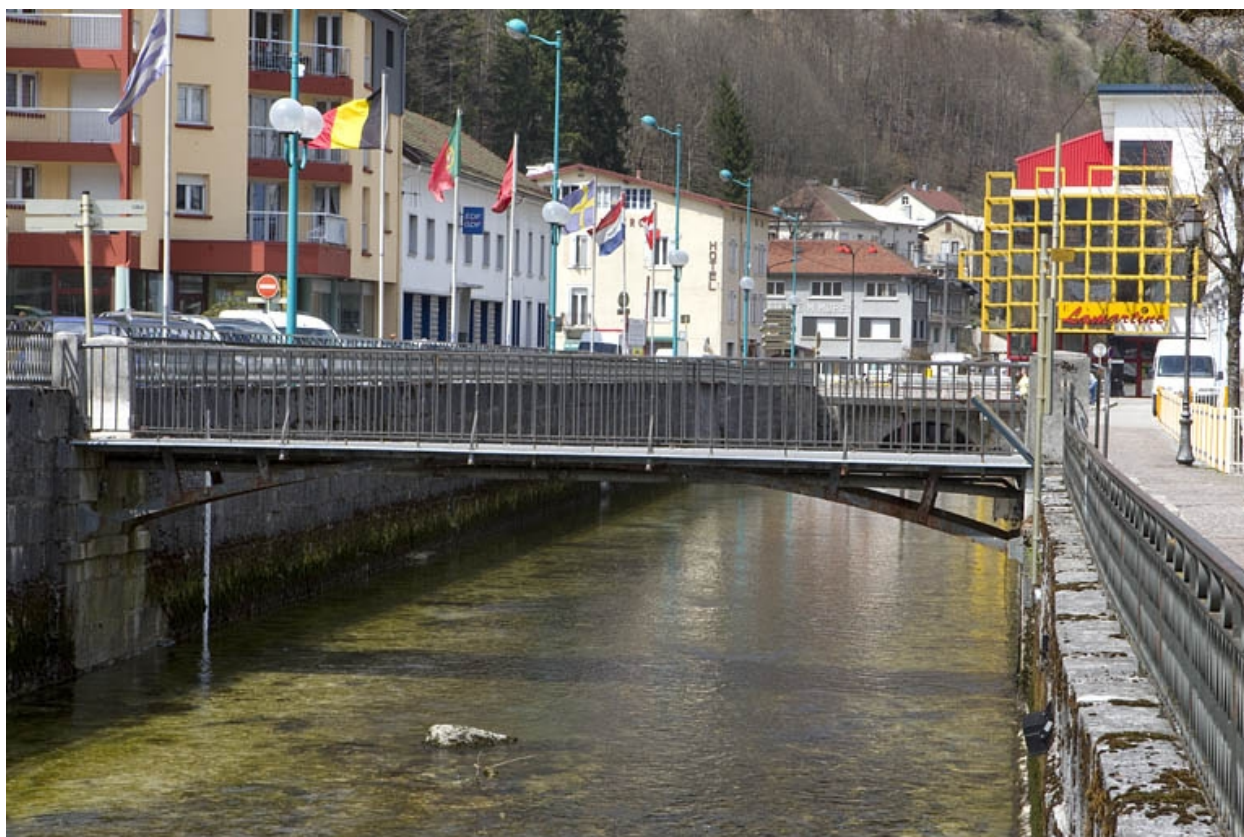
Passerelle aval, vue de l'amont.
