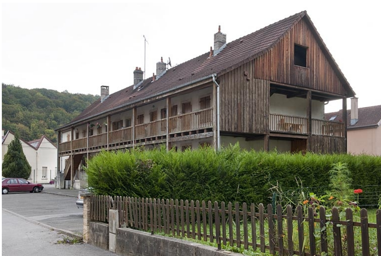
Vue de trois quarts depuis l'ouest.
