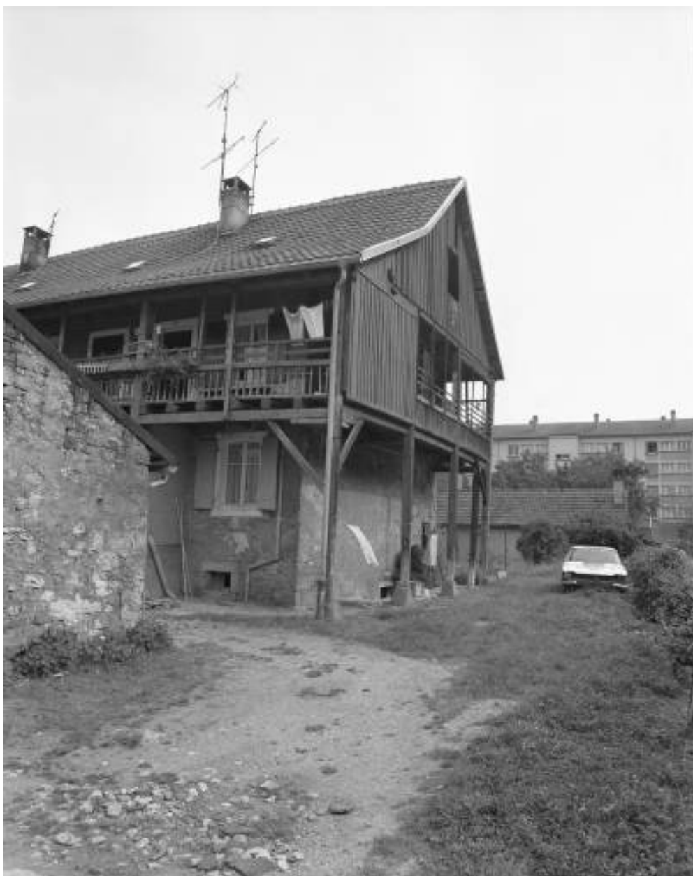
Pignon ouest en 1981.
