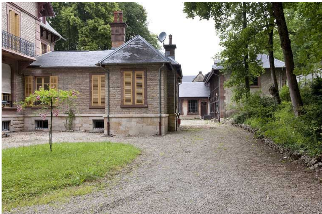
Façade sud de l'annexe et communs.
