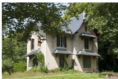
Logement du jardinier. Phot. Jérôme Mongreville IVR43_20112501167NUC4A
