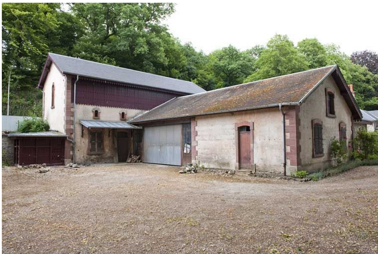
Communs vus depuis le nord-ouest.
