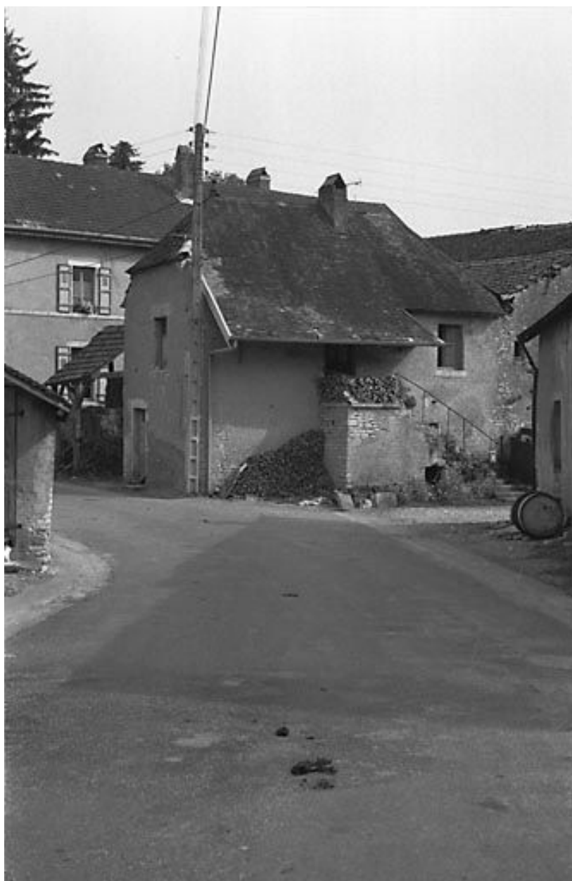
Maison située rue de la Fontaine.
