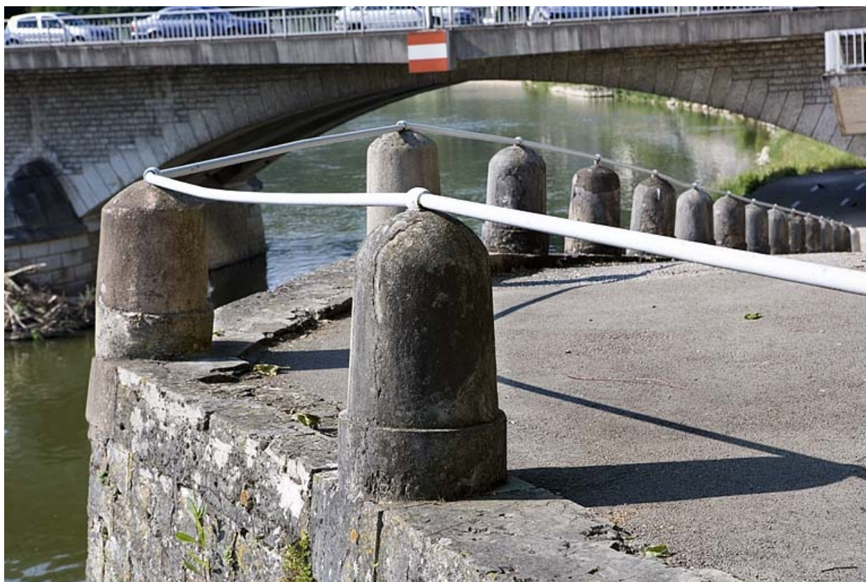
Bornes et garde-corps de la rampe d'accès.
