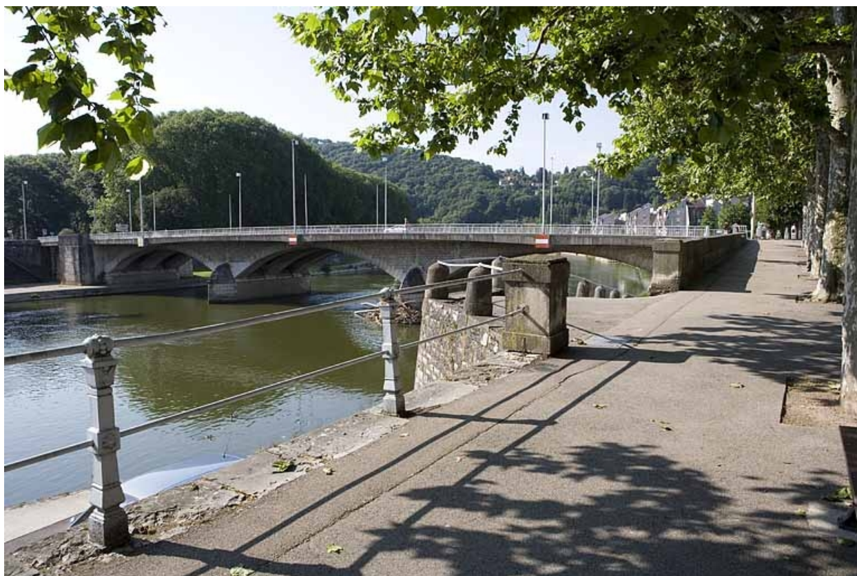
Garde-corps métallique et rampe d'accès au port.
