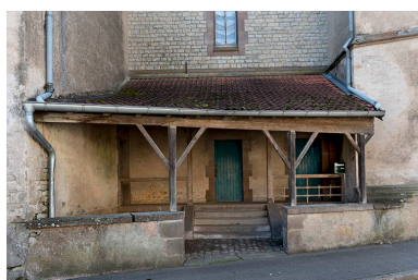
Détail de l'entrée rue Billecard. Phot. Sonia Dourlot IVR43_20157001401NUC4A
