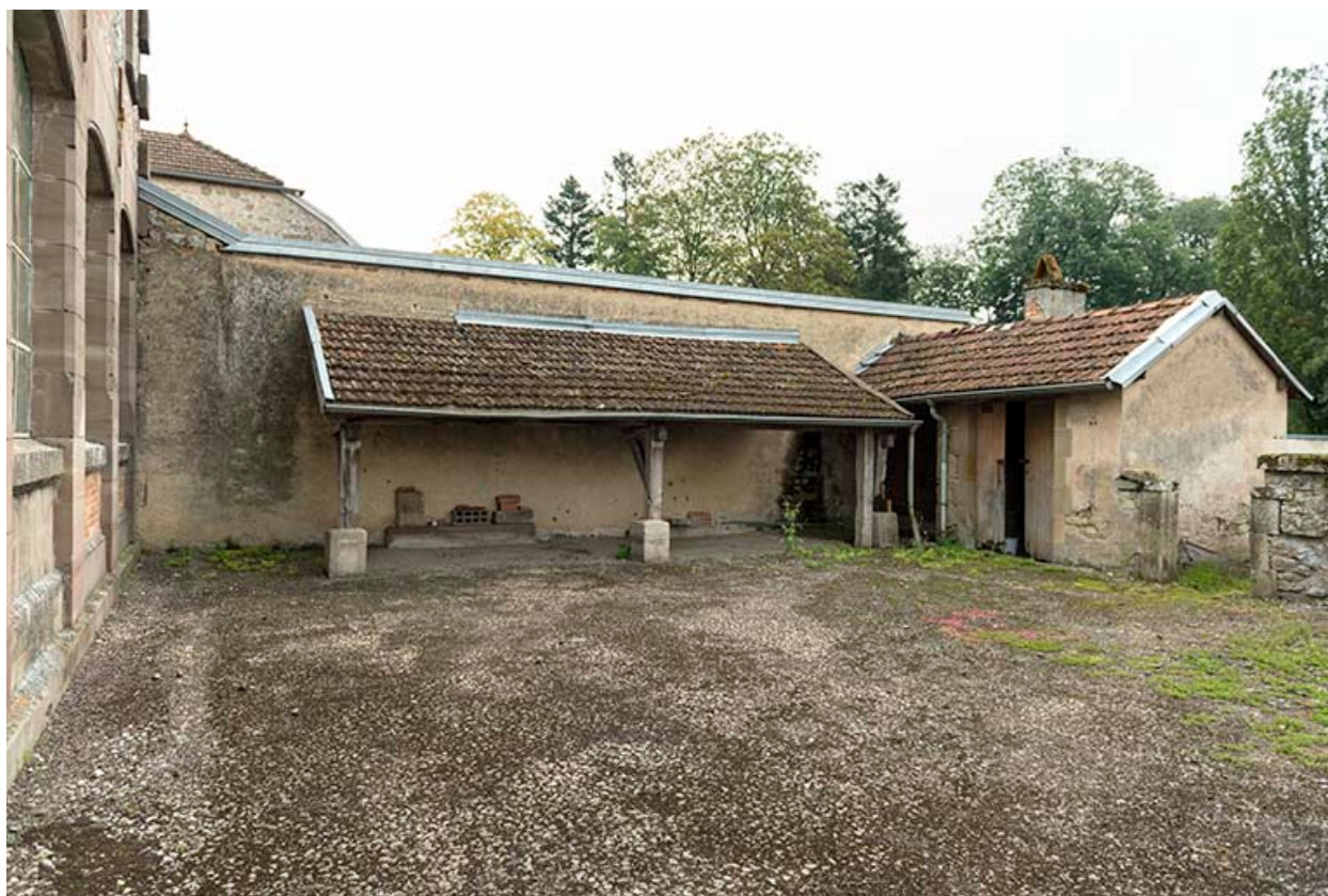
Cour, préau, toilettes, à l'arrière du bâtiment.
