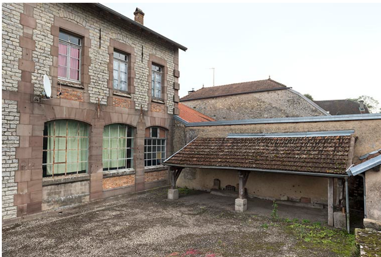
Cour, préau, détail de la façade postérieure.
