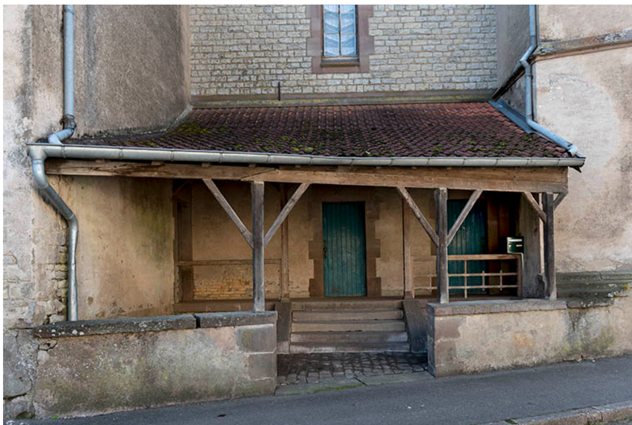
Détail de l'entrée rue Billecard.
