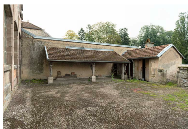
Cour, préau, toilettes, à l'arrière du bâtiment. Phot. Sonia Dourlot IVR43_20157001403NUC4A
