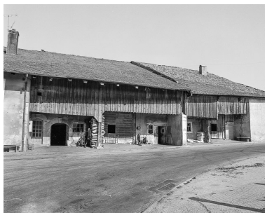
Goutterot sur rue. Phot. Dominique Dominguez
