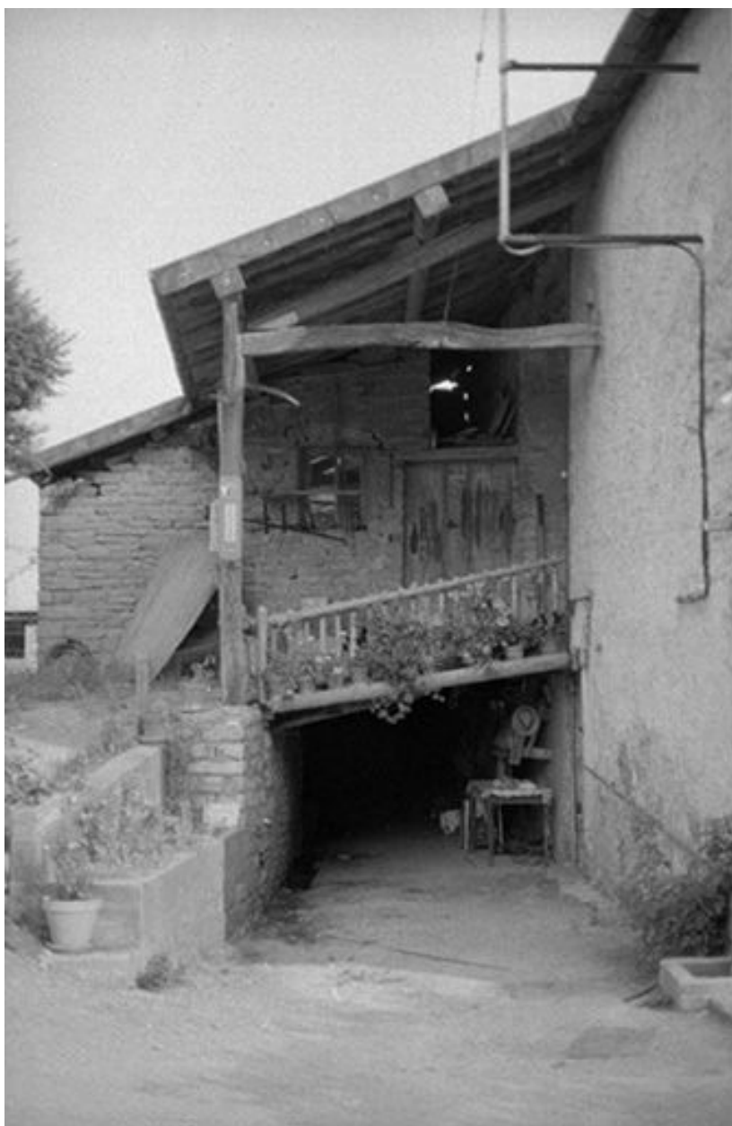
Façade latérale gauche : le pont de grange.
