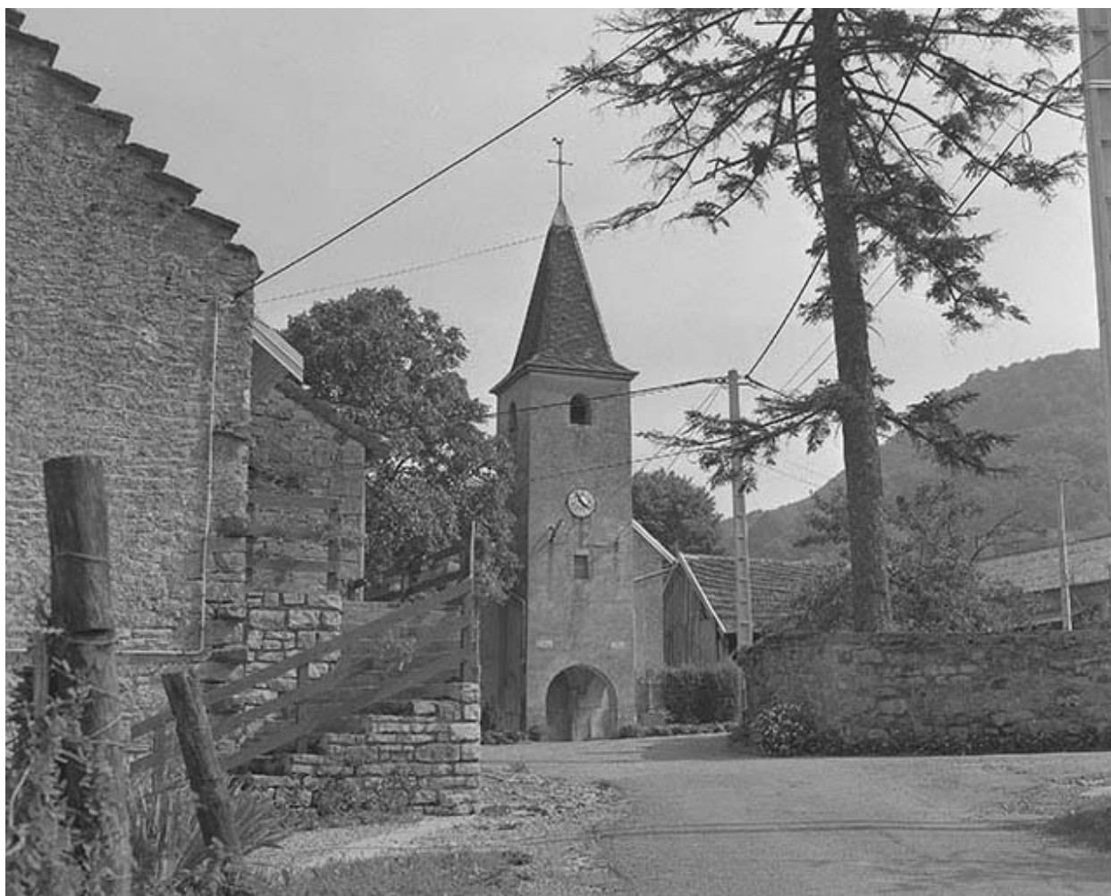
Extérieur : façade antérieure.
