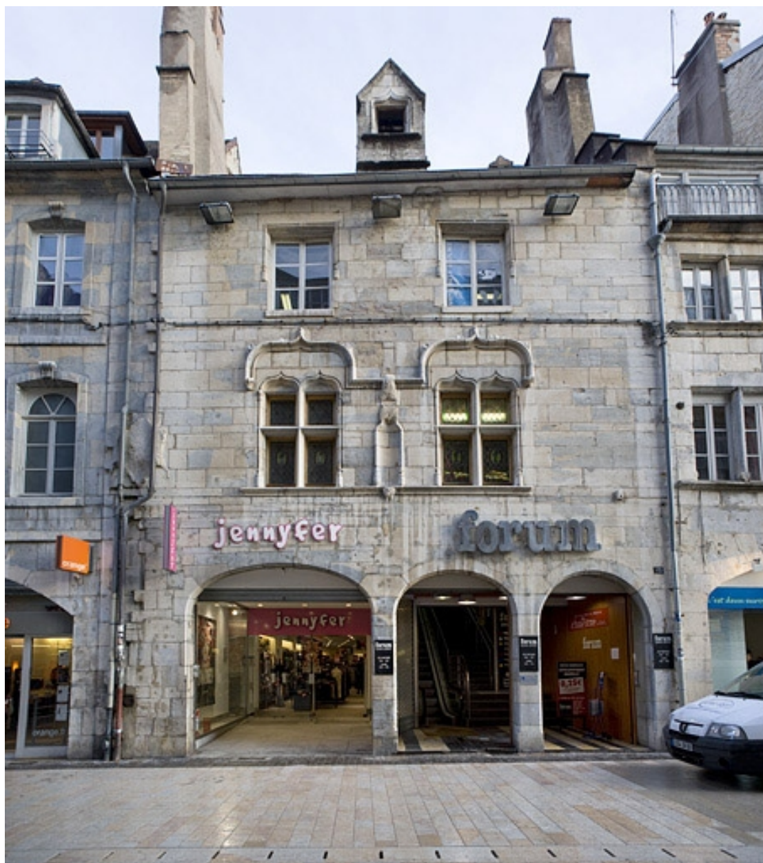
Façade antérieure du 15 Grande Rue : de face.
