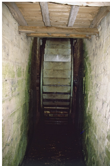
Roue hydraulique en dessus. Phot. Yves Sancey IVR43_20009000309ZA
