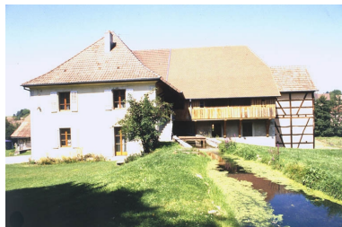
Vue d'ensemble depuis le sud-est. Au premier plan : le canal d'amenée. Phot. Yves Sancey IVR43_20009000305ZA
