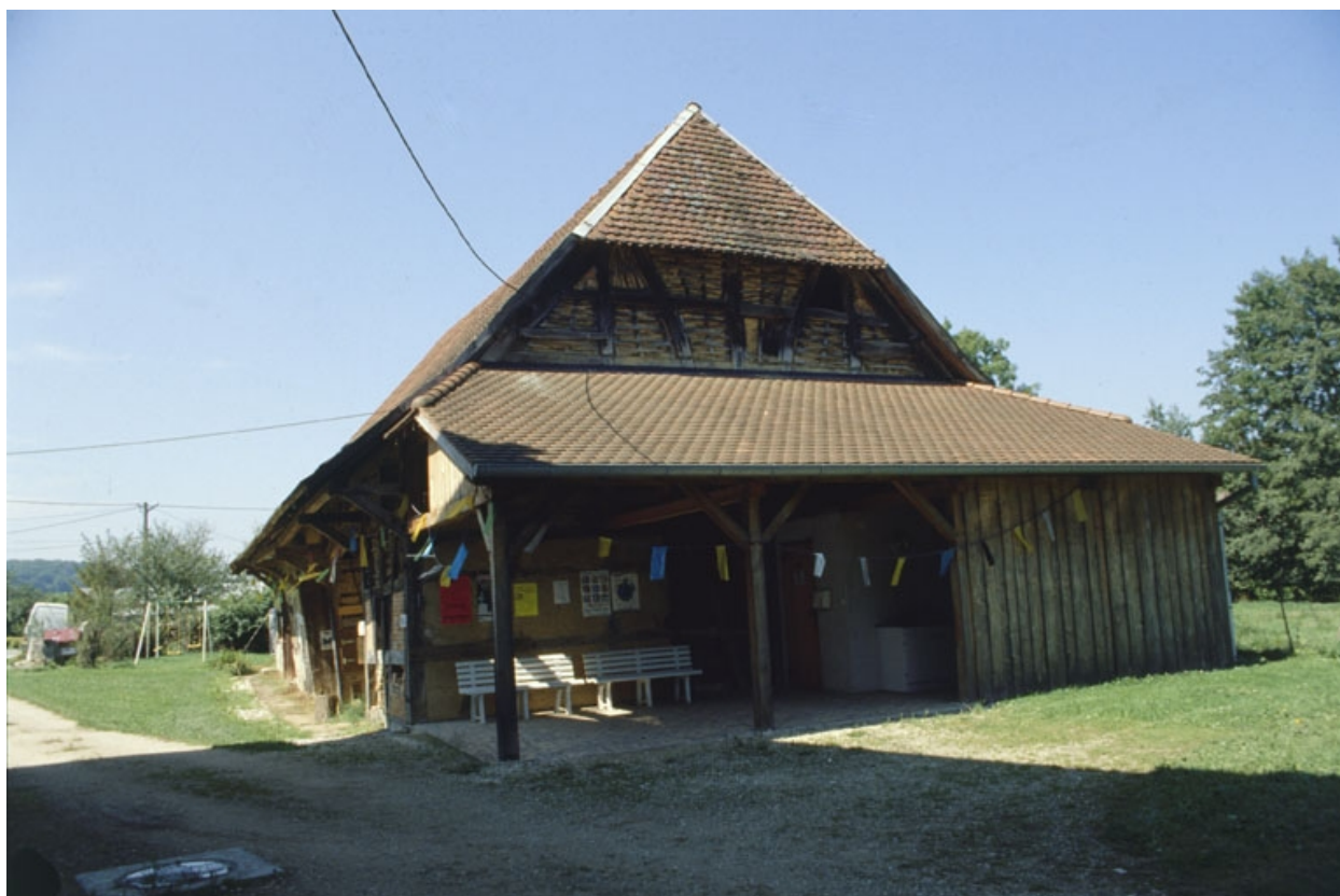
Pignon du bâtiment agricole.
