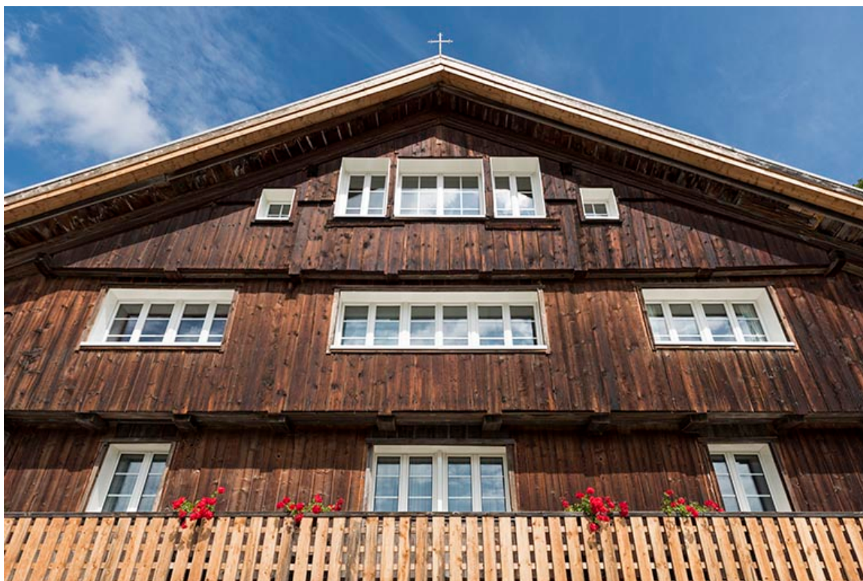
Façade antérieure, vue en contre-plongée.
