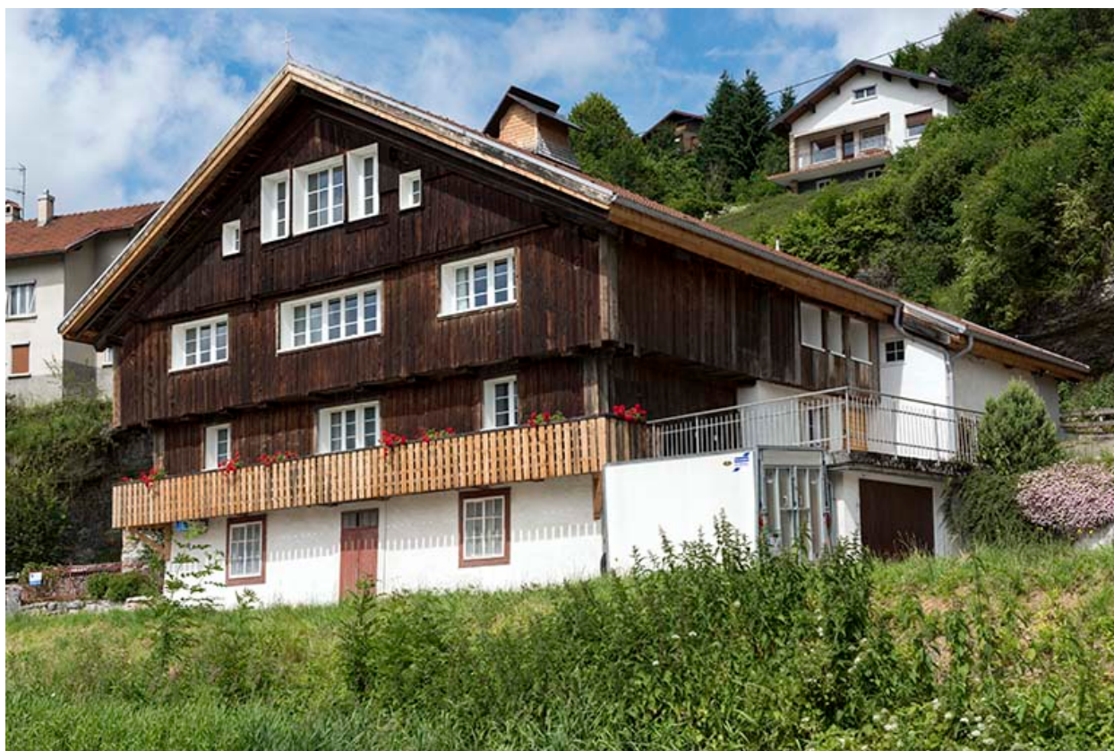
Façades antérieure et latérale droite.
