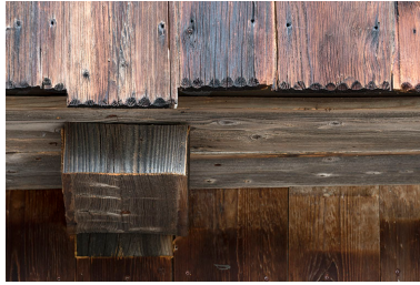
Extrémité des planches de la lambrichure. Phot. Sonia Dourlot IVR43_20162501310NUC4A
