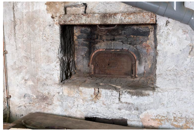
Deuxième étage de soubassement : four à pain. Phot. Sonia Dourlot IVR43_20162501312NUC4A
