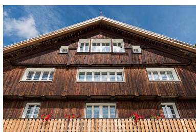
Façade antérieure, vue en contre-plongée. Phot. Sonia Dourlot IVR43_20162501307NUC4A
