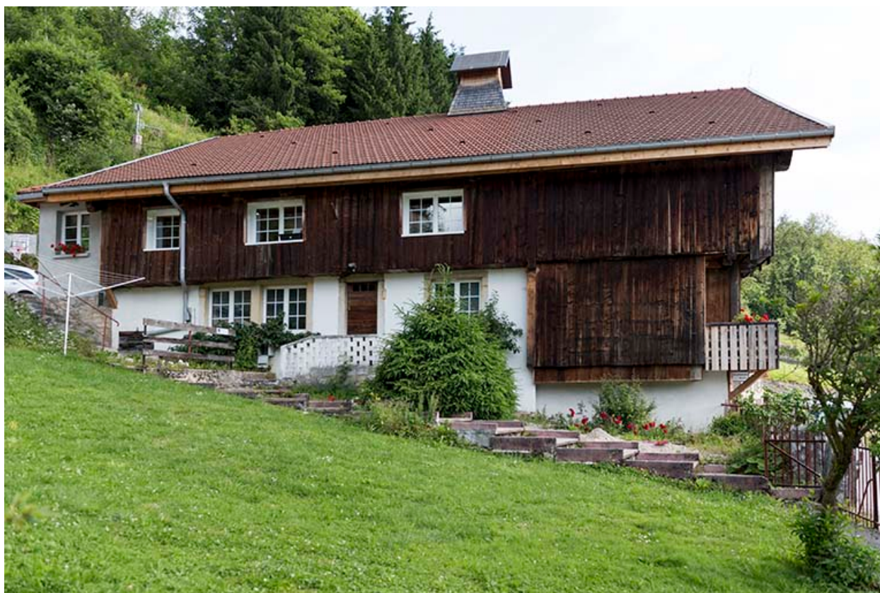
Façade latérale gauche.
