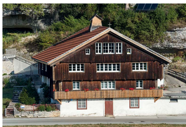
Façade antérieure, vue en plongée. Phot. Sonia Dourlot IVR43_20162501299NUC4A
