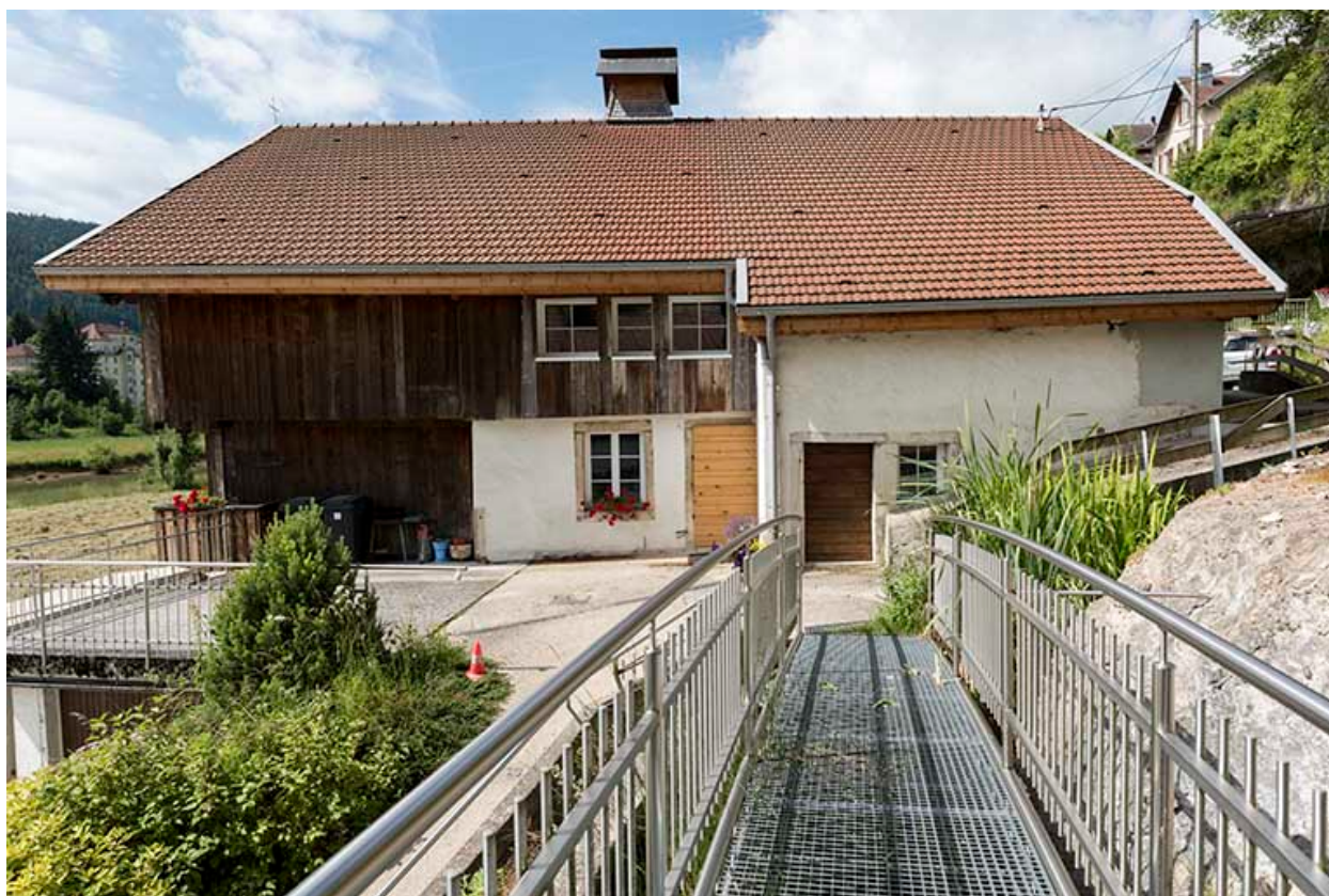
Façade latérale droite.
