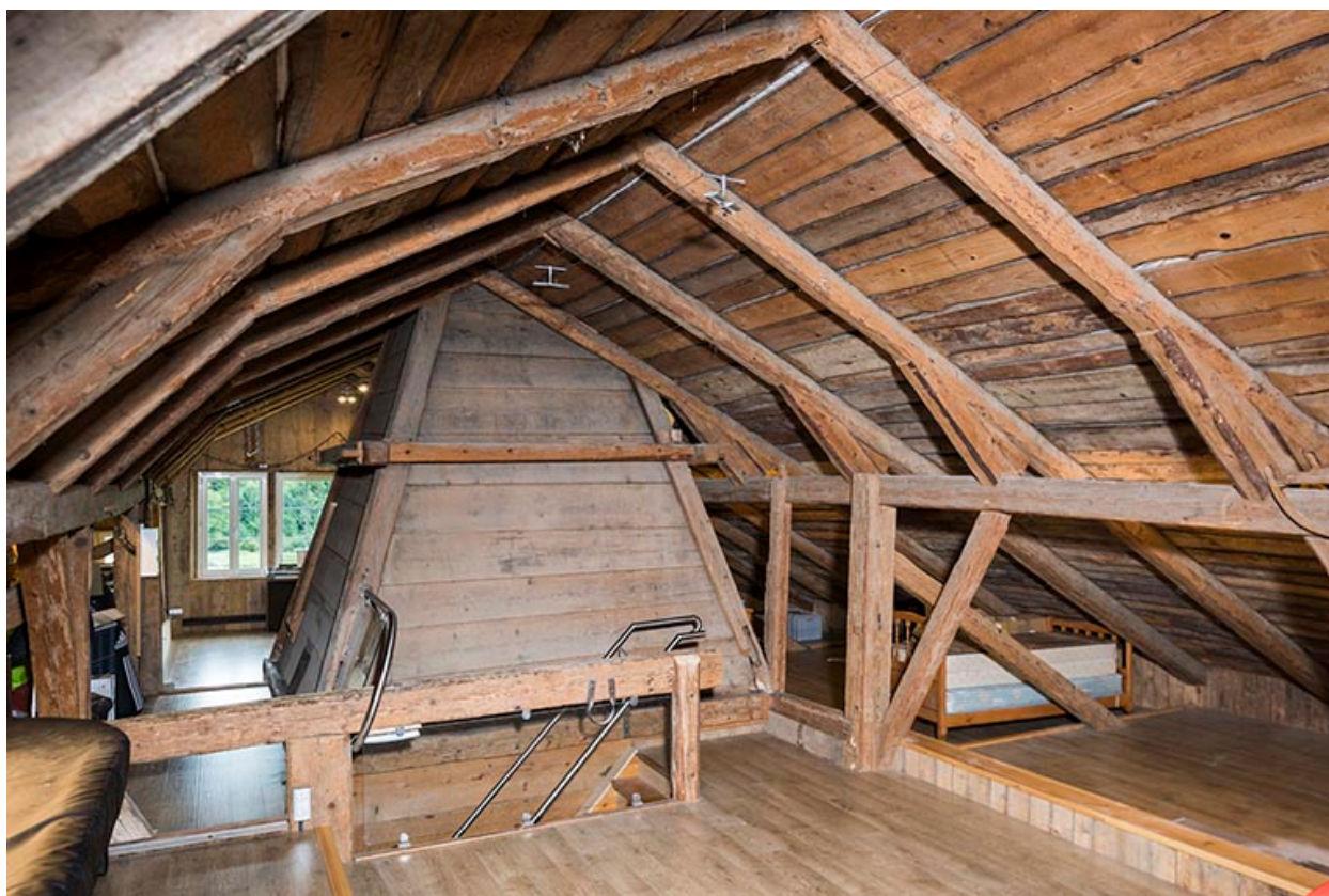
Etage en surcroît : charpente et tué.
