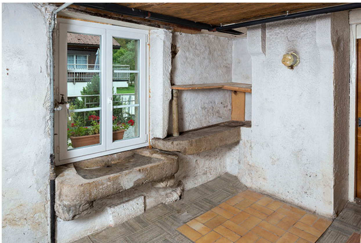
Premier étage de soubassement : ancien évier.
