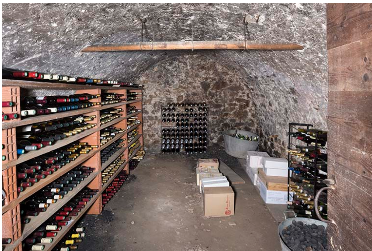
Deuxième étage de soubassement : cellier.
