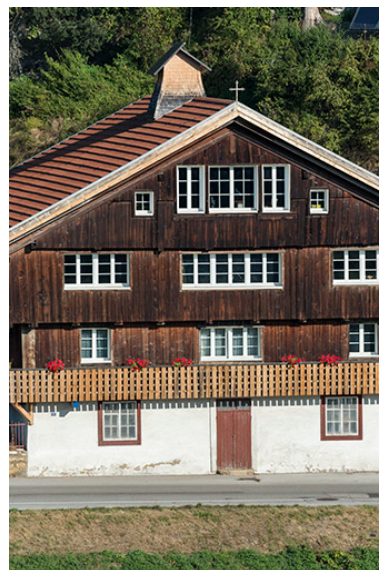
Façade antérieure : travées centrales. Phot. Sonia Dourlot IVR43_20162501300NUC4A
