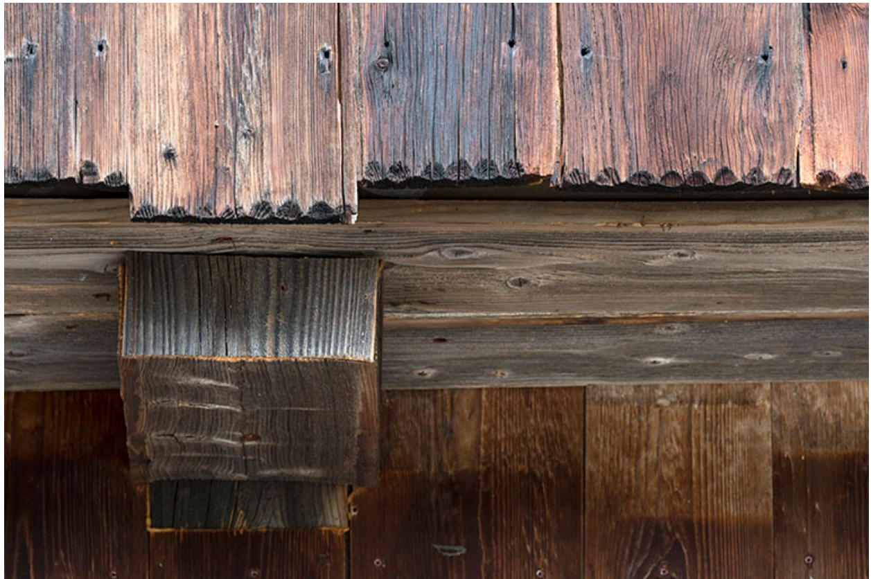
Extrémité des planches de la lambrichure.
