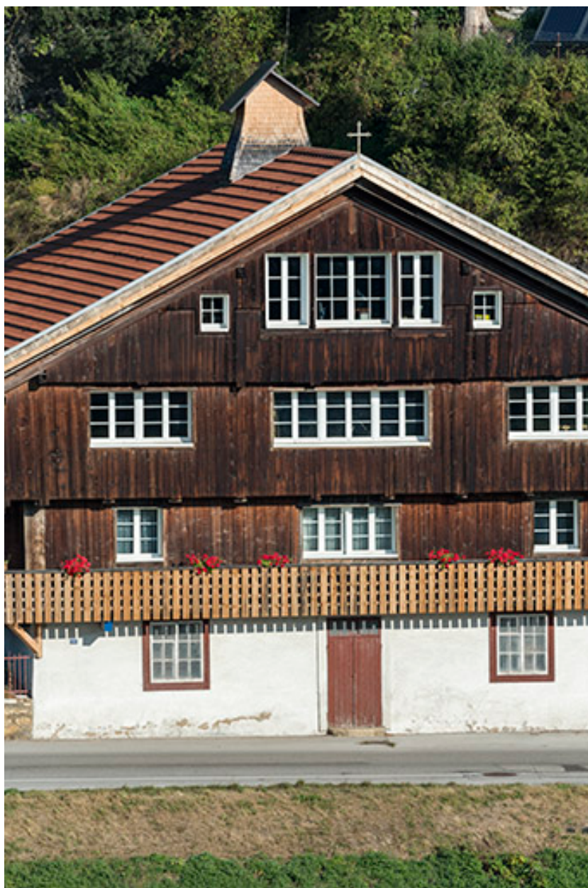
Façade antérieure : travées centrales.
