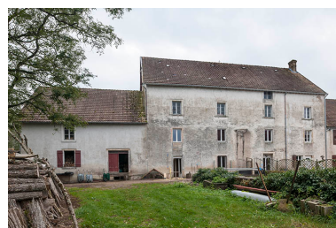
Façade ouest de l'atelier de minoterie. Phot. Jérôme Mongreville IVR43_20142501658NUC4A
