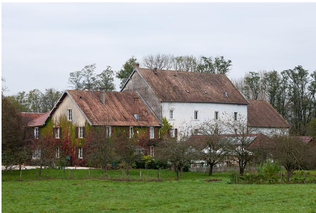
Vue depuis le sud.
