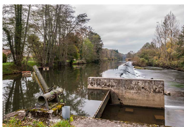
Le barrage sur l'Ognon. Phot. Jérôme Mongreville IVR43_20142501661NUC4A
