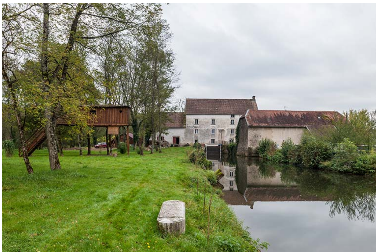
Vue d'ensemble depuis le bief d'aménée.
