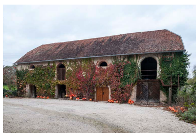
Façade est du bâtiment à fonction agricole. Phot. Jérôme Mongreville IVR43_20142501656NUC4A
