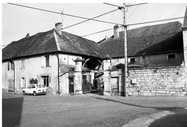
Ferme située 3 Grande Rue à Vantoux. Phot. Dominique Dominguez IVR43_19807000358X
