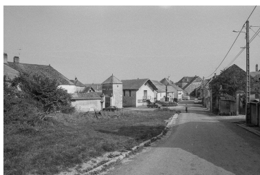
Le bas de la rue Principale. Phot. Dominique Dominguez IVR43_19807000352Z
