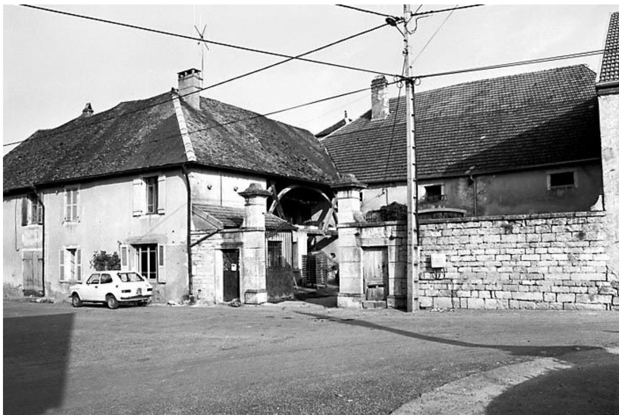
Ferme située 3 Grande Rue à Vantoux.
