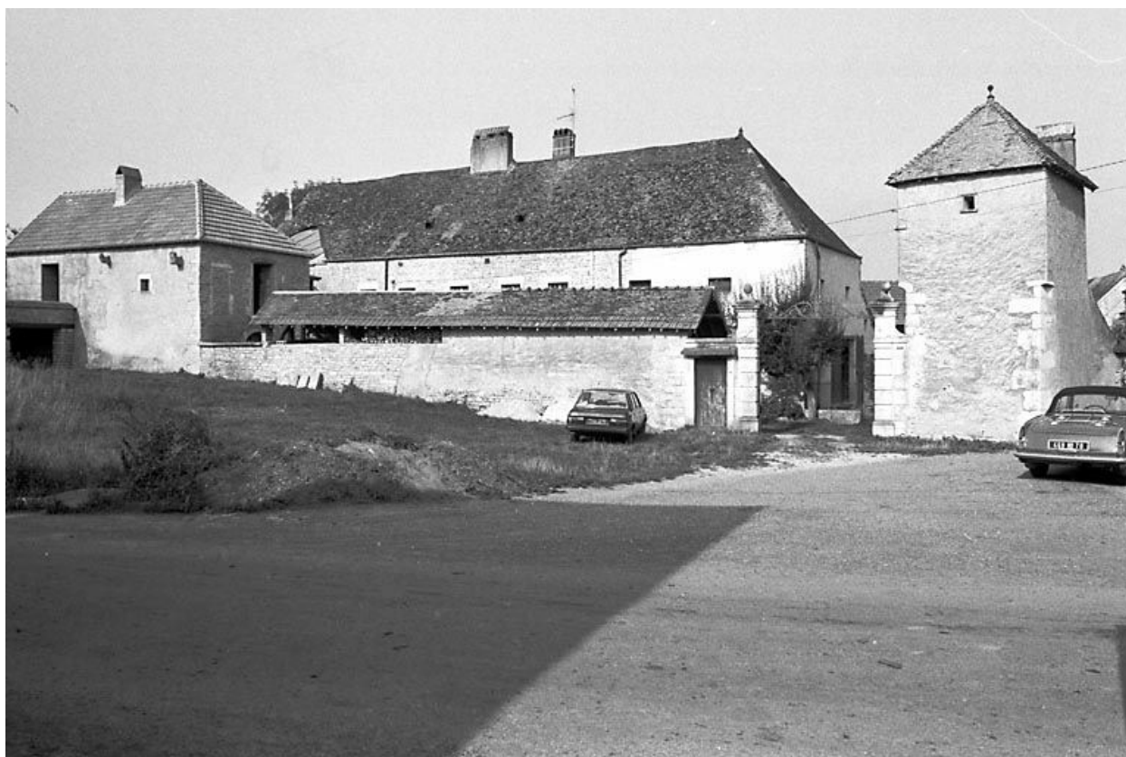
Ferme située Grande Rue à Vantoux.
