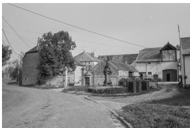
Ferme située rue du Pont Neuf à Vantoux. Phot. Dominique Dominguez IVR43_19807000374Z
