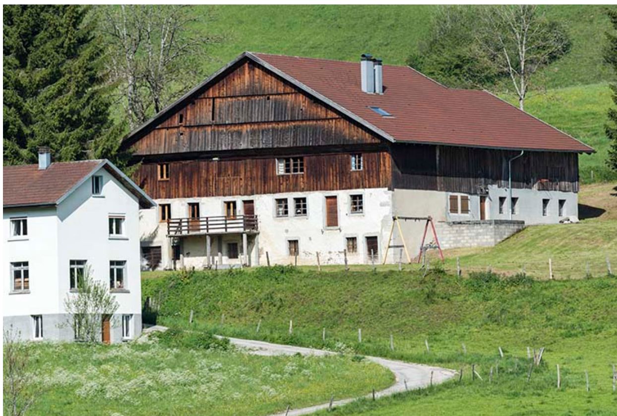
Façades antérieure et latérale droite.
