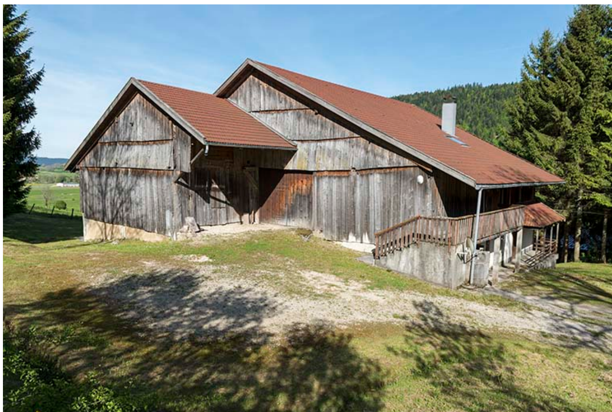
Façades postérieure et latérale gauche.
