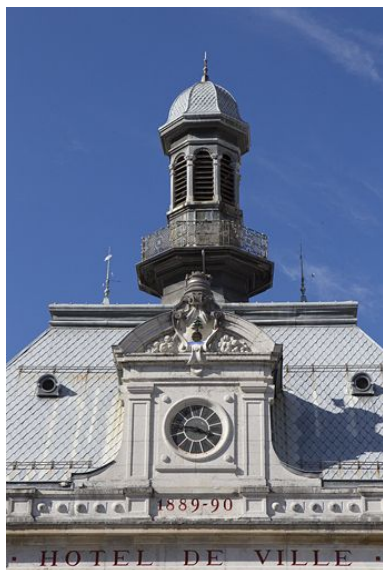
Le cadran (en 2010), intégré au fronton du pavillon central.
