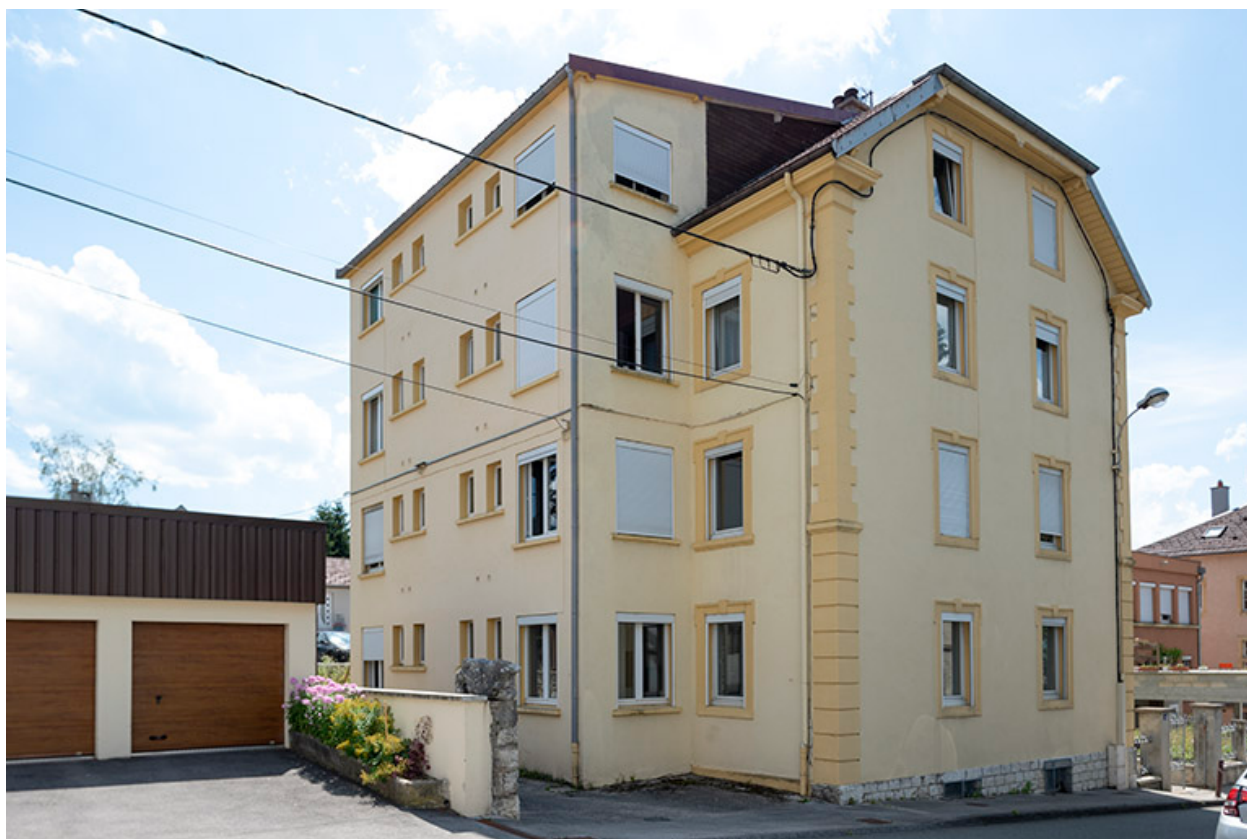
Façades postérieure et latérale gauche.
