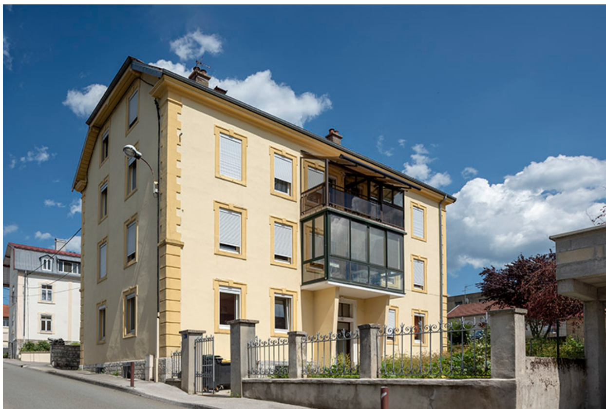
Façades antérieure et latérale gauche.
