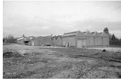
L'usine vue de l'ouest. Phot. Laurent Poupard IVR43_19883900177Z
