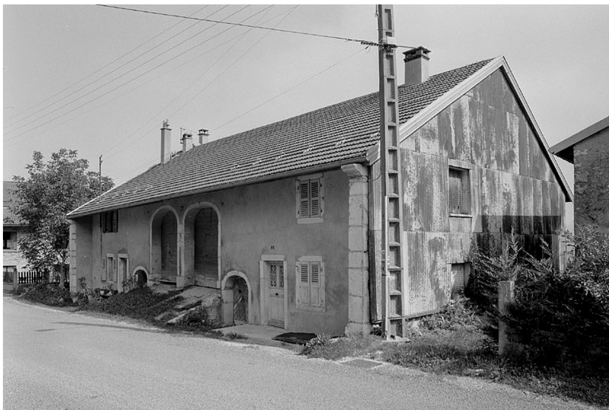
Ferme vue depuis le CD 293 E1.
