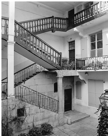
Escalier dans la cour. Phot. Yves Sancey IVR43_19833900299X
